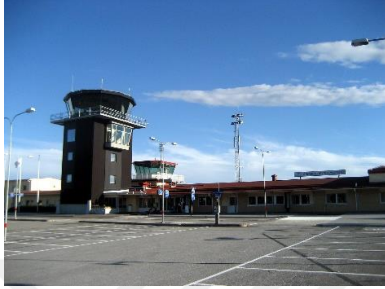
Şekil 2.7. Uzaktan Kontrolü Sağlanan Örnsköldsvick Hava Trafik Kontrol Kulesi [17]
