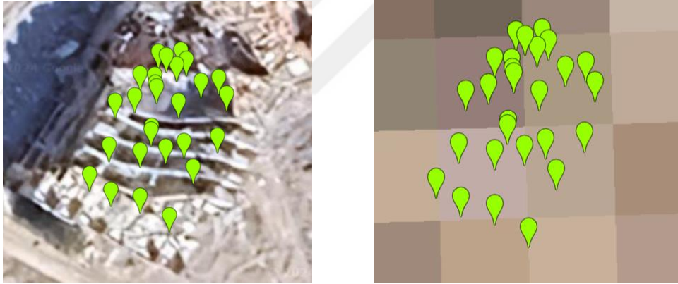
Şekil 3. 4. Yıkılmış bina Google ve Sentinel-2 uydu görüntüleri (Kaynak: GEE Platformu, 2024)
