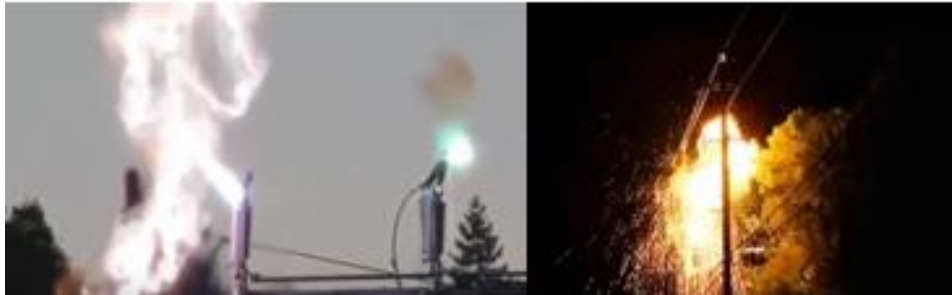
Şekil 2.3. Enerji Nakil Hattı Yangın Çıkma Anı (Karabacak, 2021)
