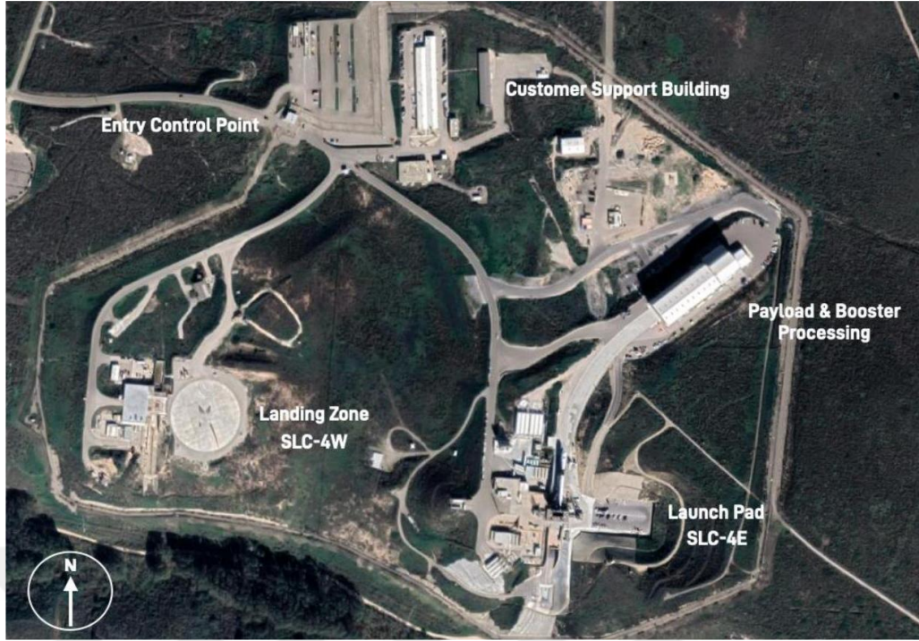
Şekil 2.21 Fırlatma Operatörü SpaceX'in Vandenberg'deki Tesisleri
