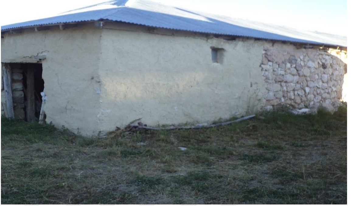
Fotoğraf 10. Ev ve Eklentilerindeki Taş Yığma Üzerine Sıva Olarak Gübre, Saman ve Su Karışımı Elde Edilerek Yapılmış Meskenlerden Bir Görünüş (Aşağı Kızılçevlik Köyü)
