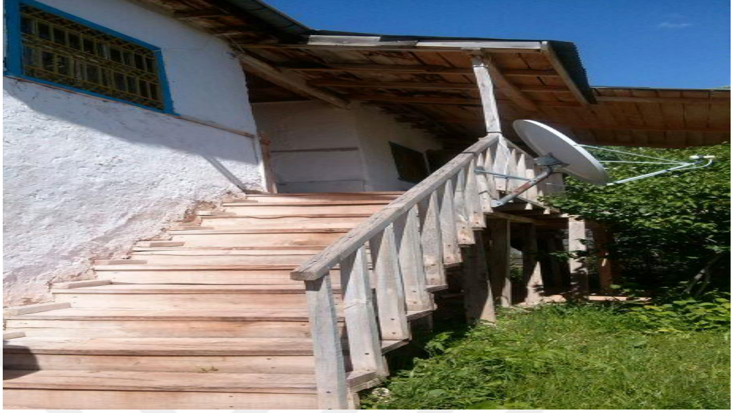
Fotoğraf 12: Geleneksel Çerkez evlerinde eğer evin altında depo veya ambar olarak kullanılan bölme varsa misafir odasının girişi evden ayrı bir merdiven ile yine evden bağımsız şekilde yapılır. (Çerkez Karaboğaz Köyü)
