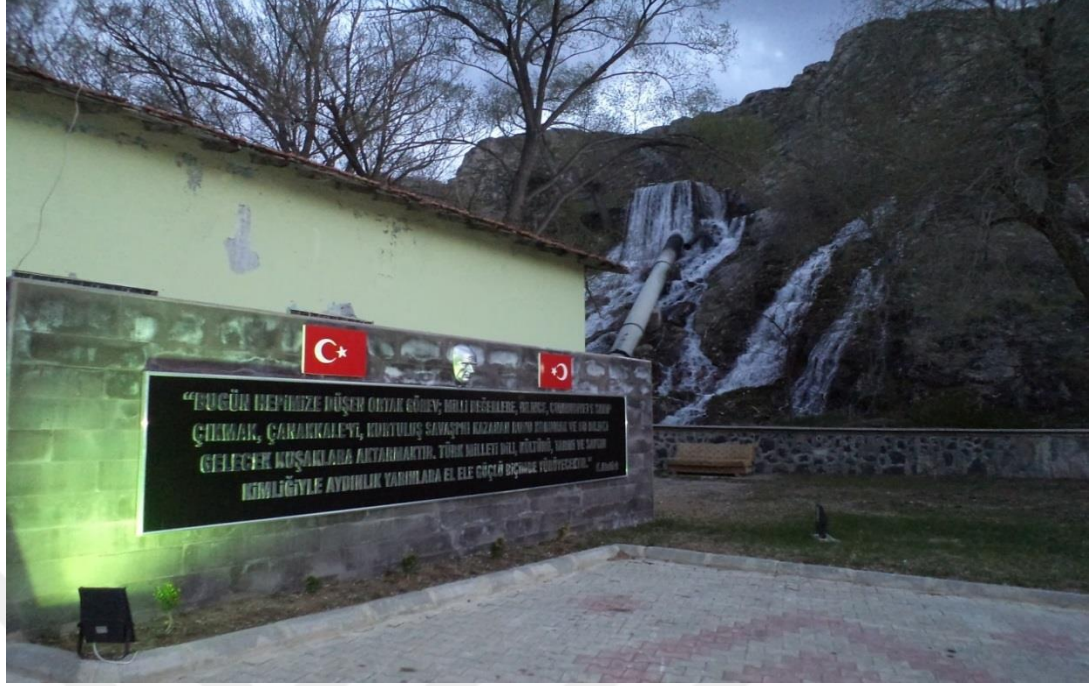
Fotoğraf 4. Pınarbaşı Merkezde ‘‘Göz’’ olarak adlandırılan kaynak suyunun çıkış noktası ve bu suyun beslediği Hidroelektrik Tesisinden Bir Görünüş.
