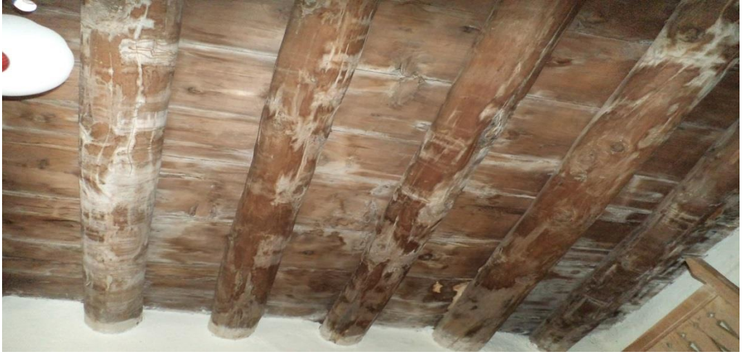
Fotoğraf 7. Evlerin çatı yapı malzemesi olarak daha esnek yapıda ve daha sağlam olan ardıç ağaçları tercih edilmektedir.
