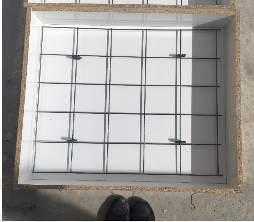
Şekil 3.9. Kalıplar içerisine hasır donatının yerleştirilmesi
