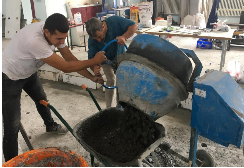
Şekil 3.10. Beton üretiminin yapılması
