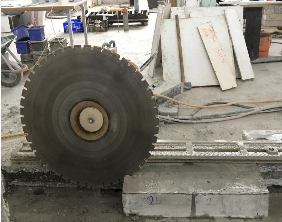
Şekil 3.29. Betonarme plaktan kiriş numunelerin kesilerek çıkarılması
