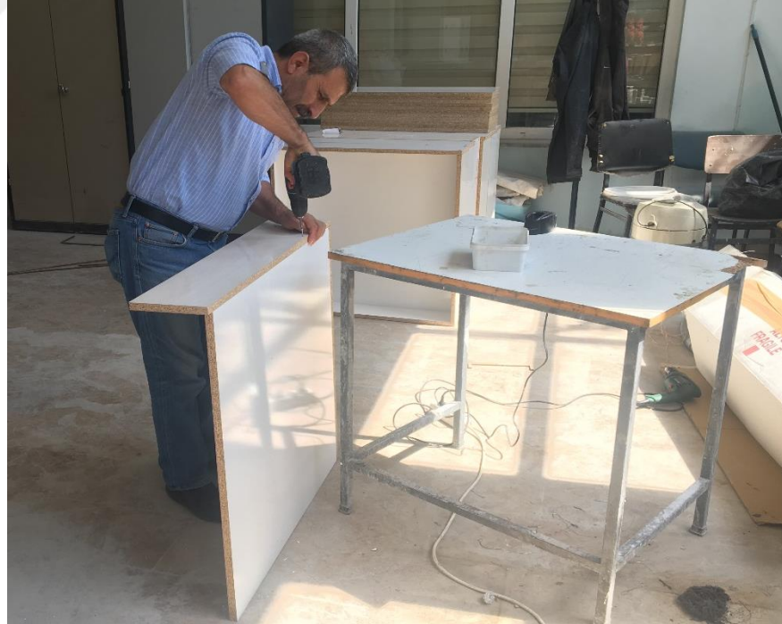
Şekil 3.8. Betonarme plaklar için kalıp üretimi
