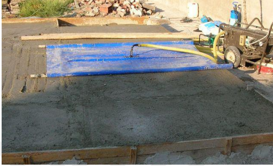
Şekil 1.1. Vakum uygulamasının yapılması(Arslan ve ark., 2010)
