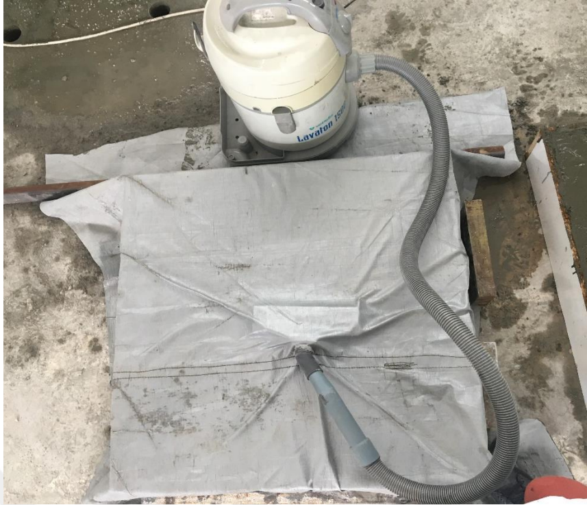
Şekil 3.14. Betona vakum uygulamasının yapılması
