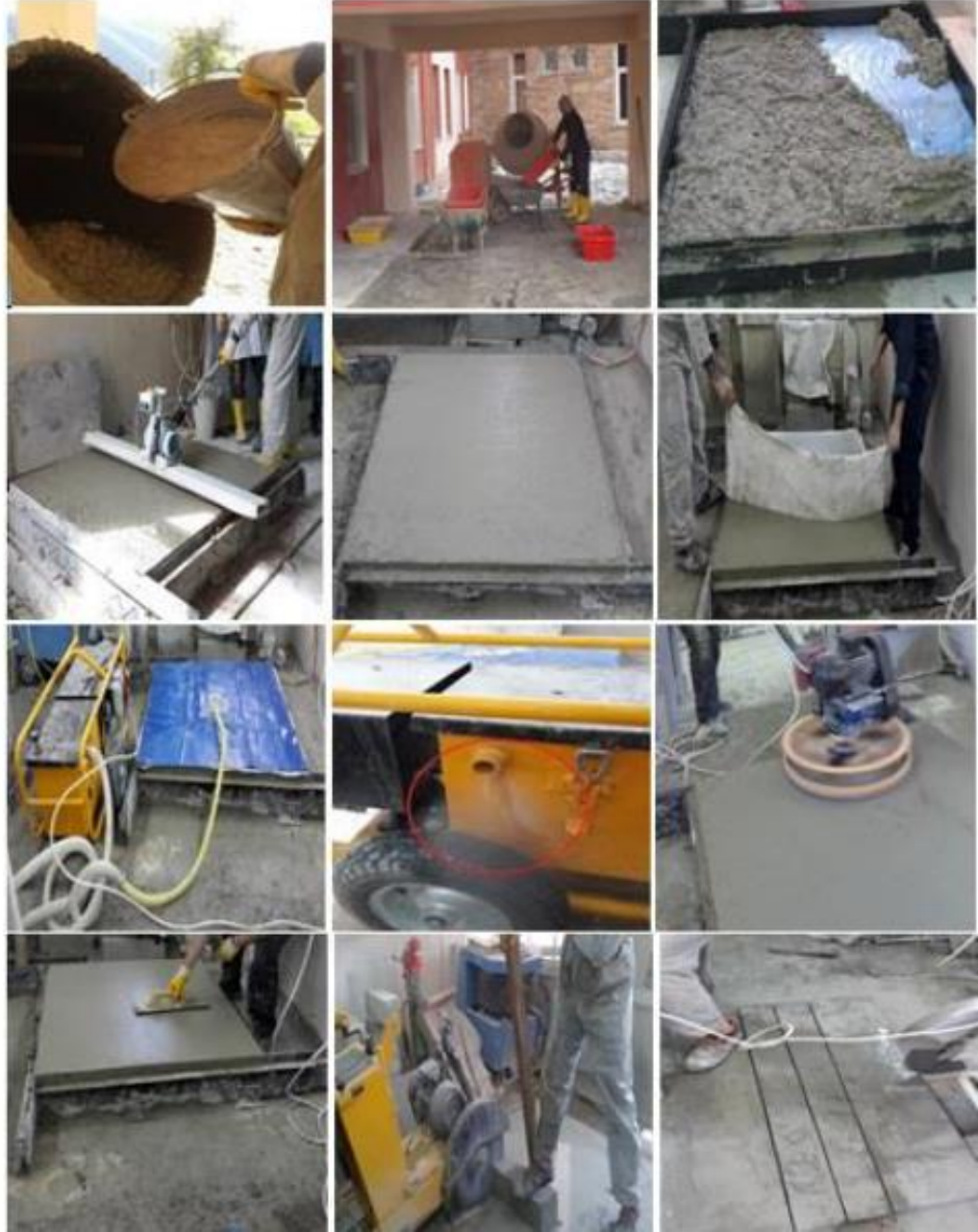
Şekil 1.9. Vakumlu beton üretim aşaması( Şahin, 2016)
