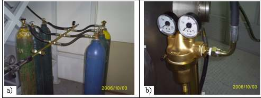
Resim 5.3. Gaz sistemi a) Yüksek basınçlı tüpler, b) Basınç ayar vanası [53]
