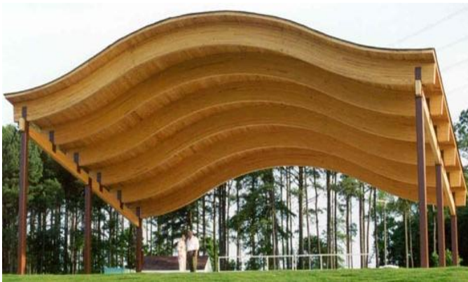
Resim 2.3. Lamine ahşap malzeme ile yapılmış çatı sistemi [Timber Design, 2001] ve lamine ahşap malzeme ile yapılmış dinlenme koltuğu [Aalto, 1932].
