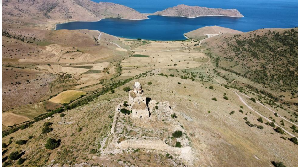
Şekil 2.29 Saint Thomas Manastırı batı cephesi hava fotoğrafı
