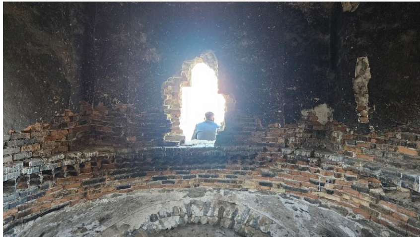
Şekil 3.39 Saint Thomas Kilisesi kubbe tuğla malzeme
