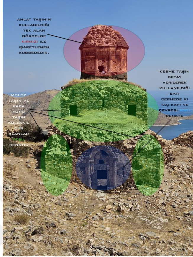
Şekil 3.35 Saint Thomas Kilisesi görünüm ve taş malzeme kullanımı
