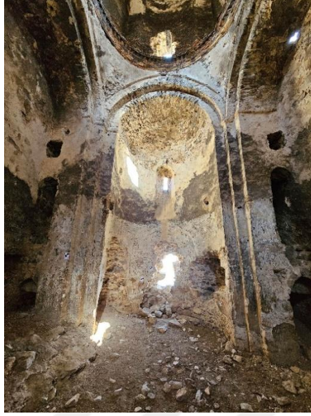
Şekil 2.11 St. Thomas Kilisesi Apsis Bölümü
