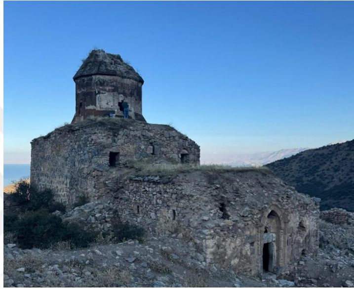
Şekil 3.10 Saint Thomas Kilisesi güneybatı görünüşü
