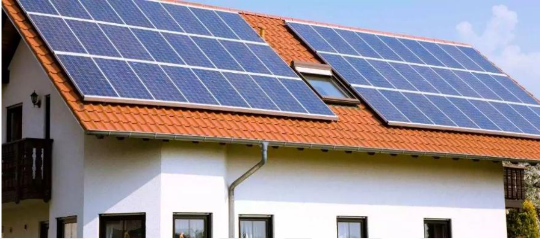
Şekil 2.3. Bina entegreli fotovoltaik (BIPV) çatı uygulaması (Anonim, 2025b)
