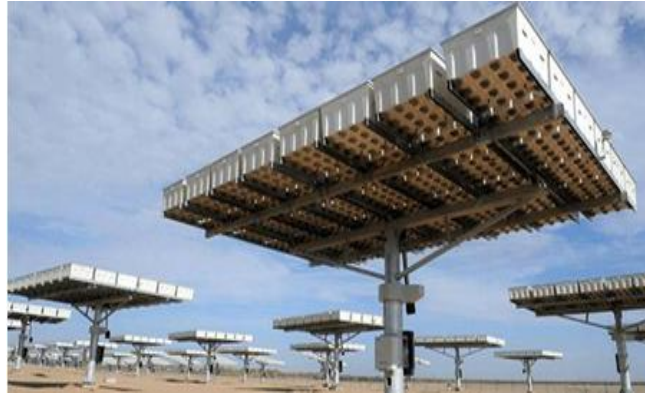
Şekil 2.10. İki eksenli güneş takip sistemi (Anonim, 2025f)
