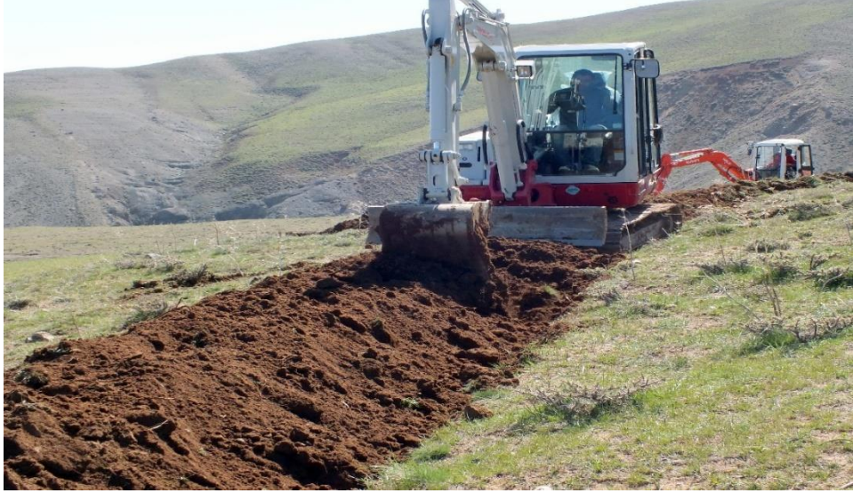
Şekil 2. Ekskavatörle gradoni şeklinde toprak işleme
