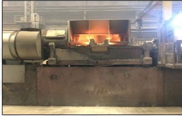
Şekil 3.3 : 14 ton kapasiteli indüksiyon ocağı
