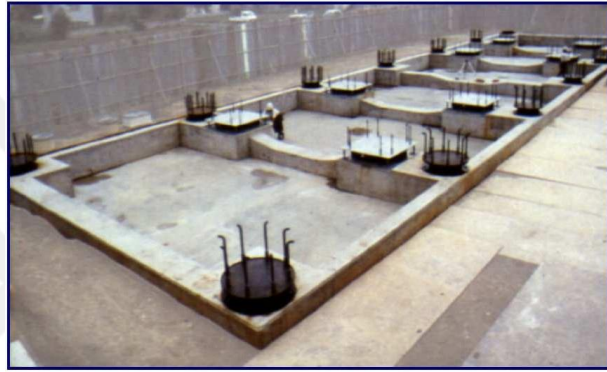
Şekil 3. Sismik izolatörlü kolon bağlantı filizleri
