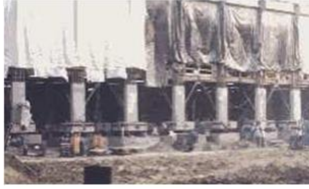
Şekil 2. Sismik izolasyon uygulanmış yapı ile yer ayrımı
