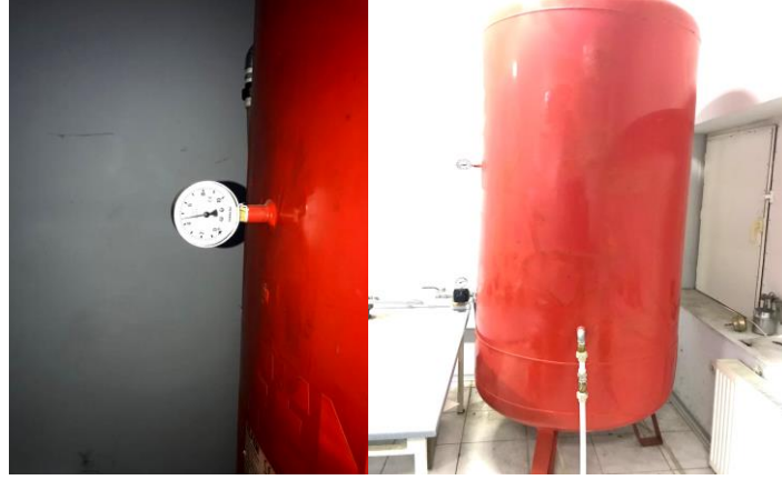
Şekil 4.9. Basınç göstergeli basınçlı hava deposu
