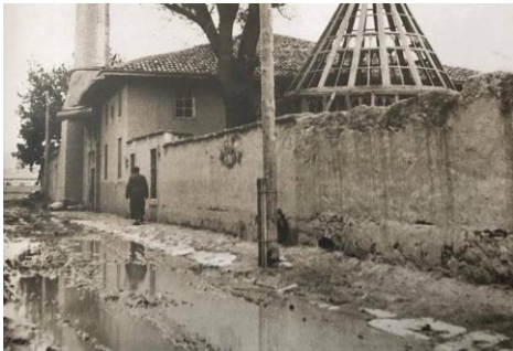
Şekil 4.14. Güneydoğu cephesi 1930 (URL 3)
