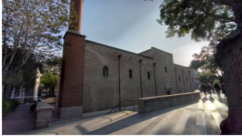
Şekil 4.98. Kuzeydoğu cephesi (Kemerçi, 2023)
