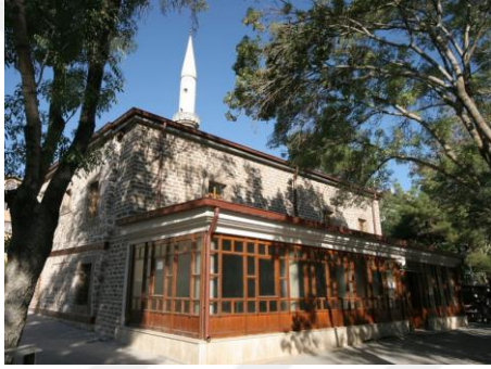
Şekil 4.115. Son onarım öncesi güneydoğu cephesi (URL 11)
