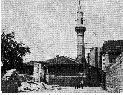
Şekil 4.10. Batı cephesinin yaklaşık 130 yıl önceki hali (Özönder, 1989)
