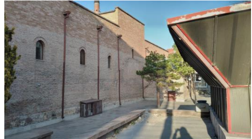
Şekil 4.101. Güney cephe ve otopark havalandırması (Kemerçi, 2023)
