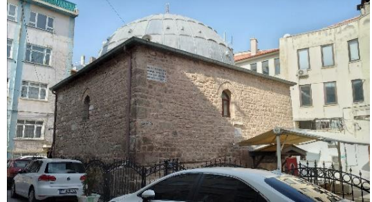
Şekil 4.53. Doğu cephesi günümüz (Kemerçi, 2023)
