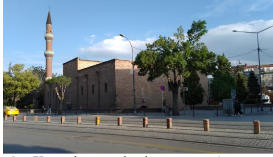
Şekil 4.95. Kuzeybatı cephesi günümüz (Kemerçi, 2023)
