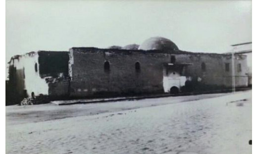
Şekil 4.103. 1930 minarenin yıkılmış durumu (URL 10)
