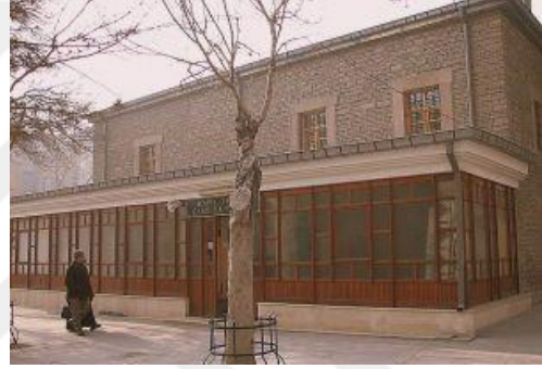
Şekil 4.116. Son onarım öncesi kuzeydoğu cephesi (Mehmet Uçan arşivi)
