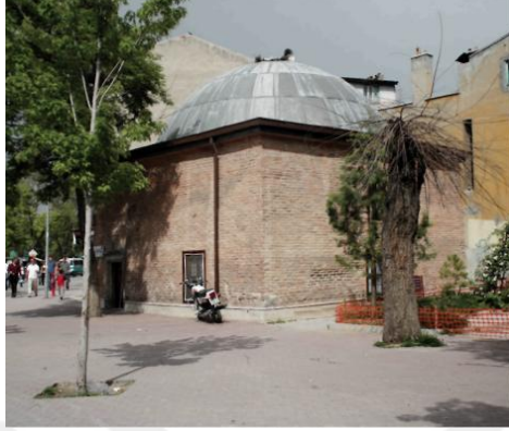
 ekil 4.73. Onarımdan  nce (URL-6)
