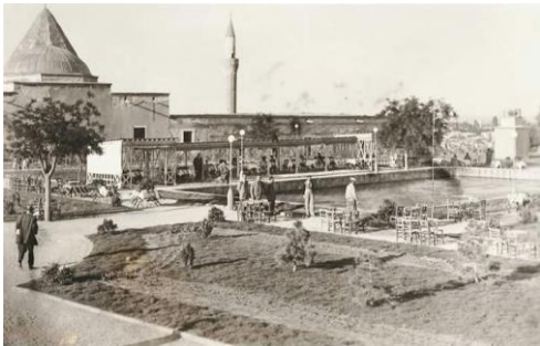
Şekil 4.89. Güney cephesi ve bahçesi (Tevfik Ataberk arşivi)
