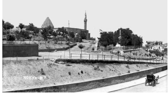
Şekil 4.88. Tepe ve caminin güneydoğudan görünümü (URL 9)
