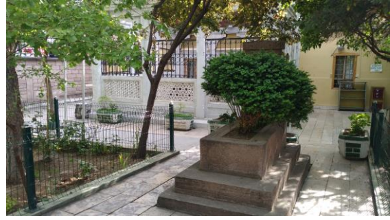
Şekil 4.17. Doğu cephesi günümüz (Kemerçi, 2023)
