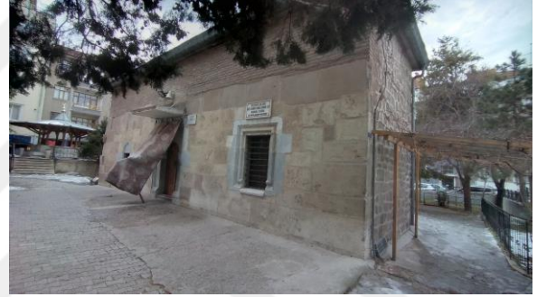
Şekil 4.63. Kuzeydoğu cephesi (Kemerçi, 2023)
