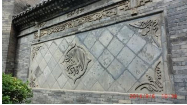
Resim 17 : Ulu Cami İçindeki Arapça Tuğla Duvarı
