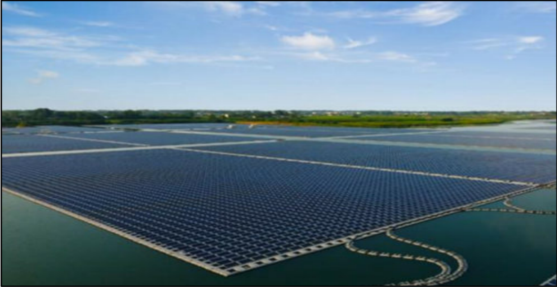
Şekil 2.7 Yüzer güneş enerji santrallerine örnek bir tesis.
