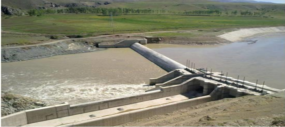
Şekil 2.18 Akarsu tipi HES’lere örnek; 4.80MW kurulu güce sahip Erzurum Karasu 4-2 HES.
