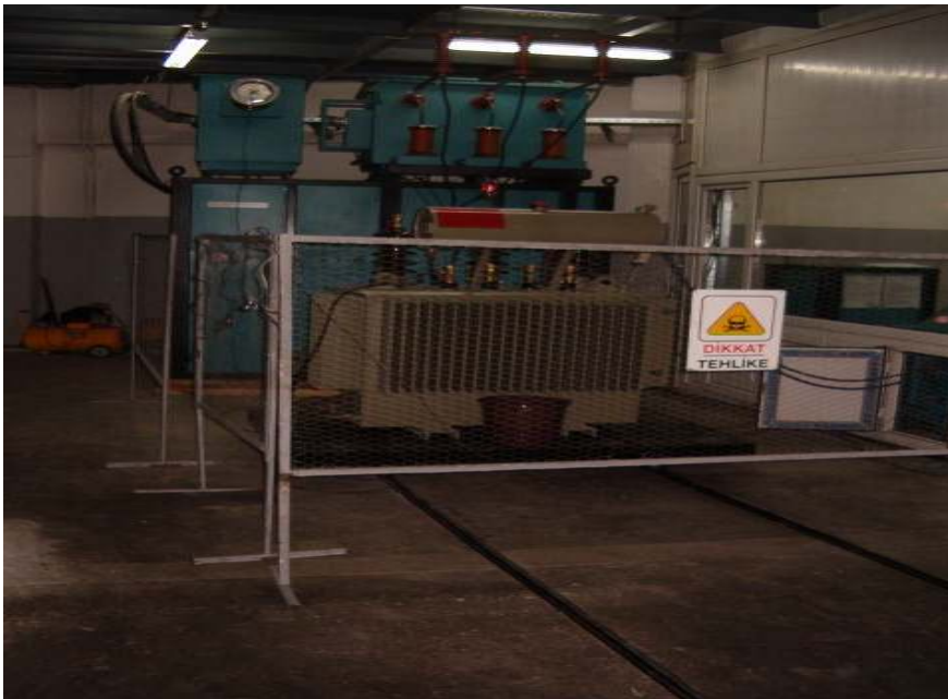
Resim 3.4. Dağıtım transformatörü kısa devre test altında
