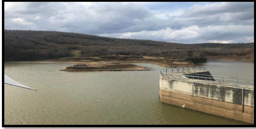
Fotoğraf 1.1. Yalıköy İSKİ Düzdere Barajı
