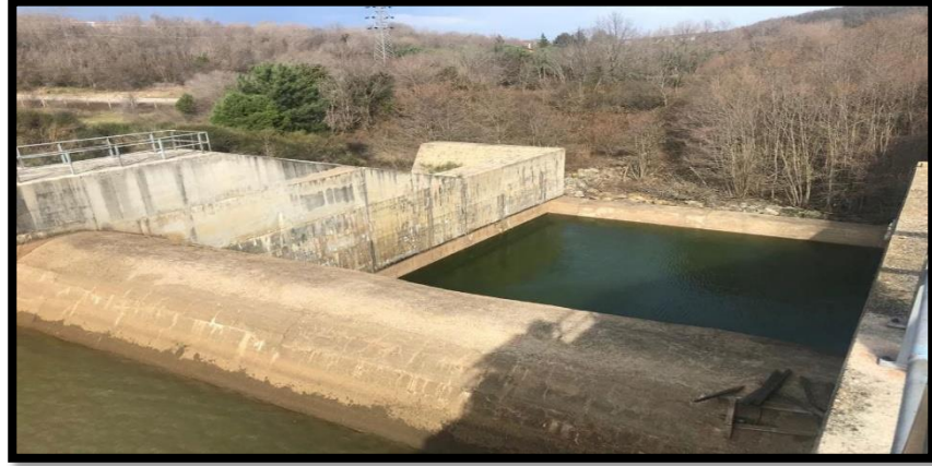
Fotoğraf 1.3. Yalıköy Düzdere Barajı
