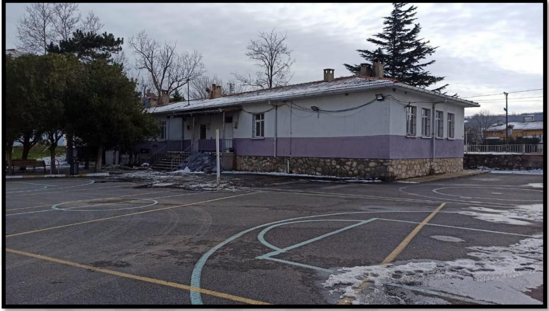
Fotoğraf 2.3 Yalıköy eski okul binası
