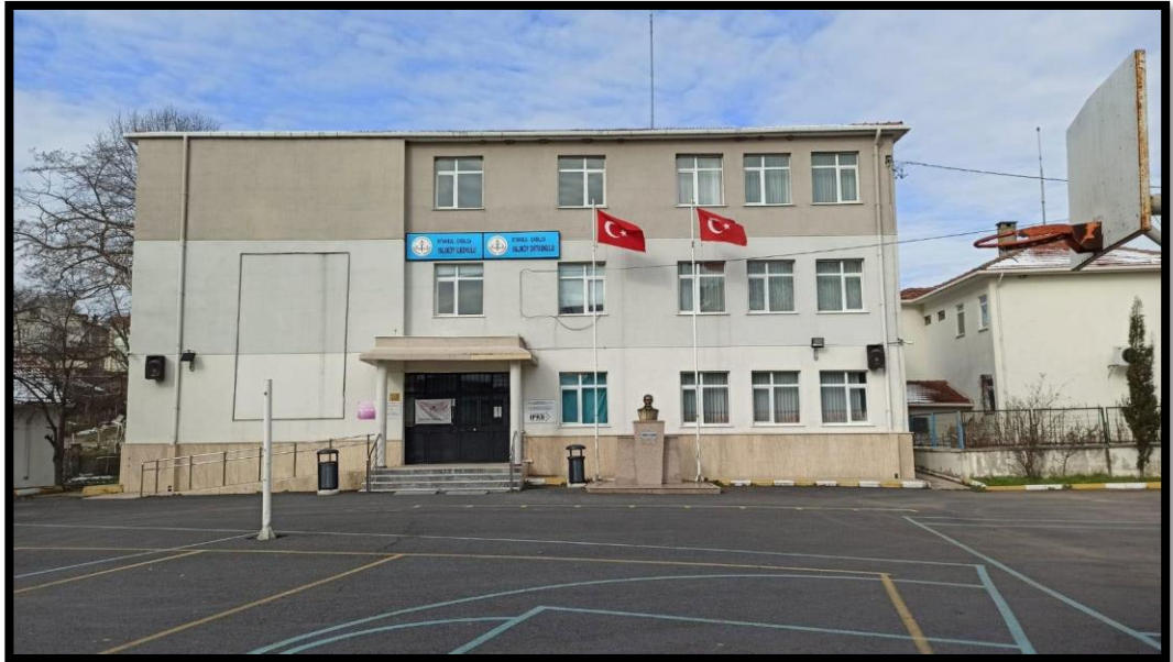
Fotoğraf 2.4 Yalıköy yeni okul binası
