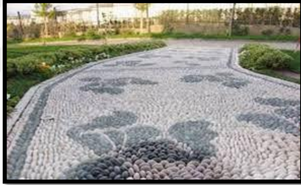
Fotoğraf 0.3 Podima döşeme sistemiyle yapılmış bir yürüyüş yolu.
