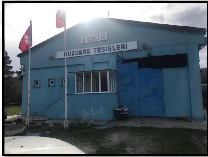
Fotoğraf 1.2. Yalıköy Düzdere Barajı Tesisi
