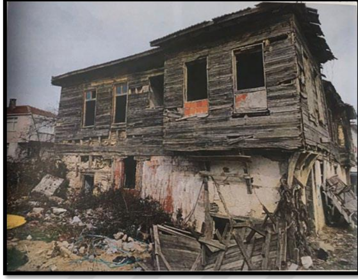
Fotoğraf 4.19 Restore edilmesi önerilen köy evlerinden biri
