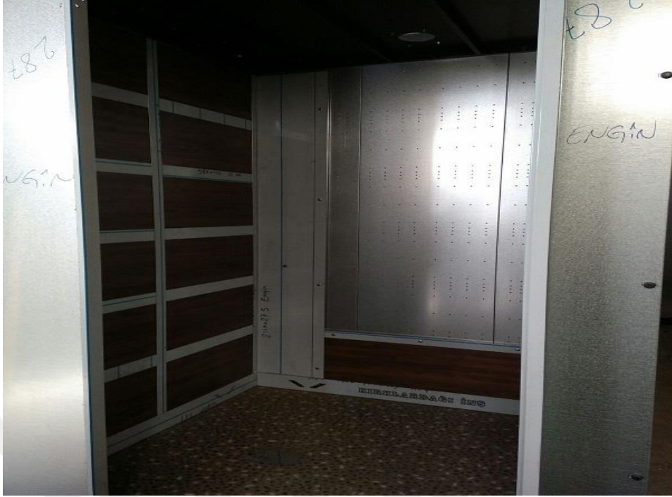
Şekil 12: Montaj İşlemi Tamamlanmış Kabin Örneği
