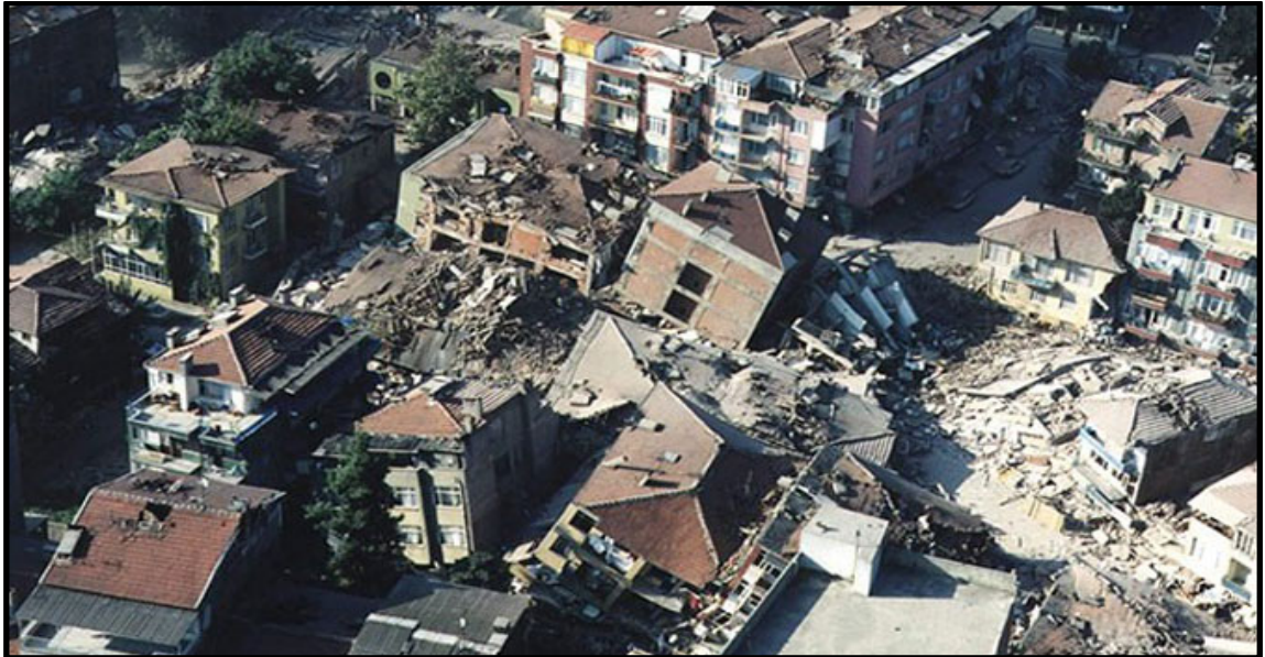
Şekil 2.6. Devirsel hareketlilik sebebiyle hasar görmüş binalar (Anonim 2017a)
