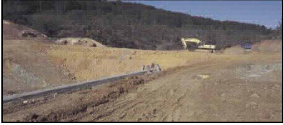
Fotoğraf 2.5: Yumrudere Baraj İnşaatı.
