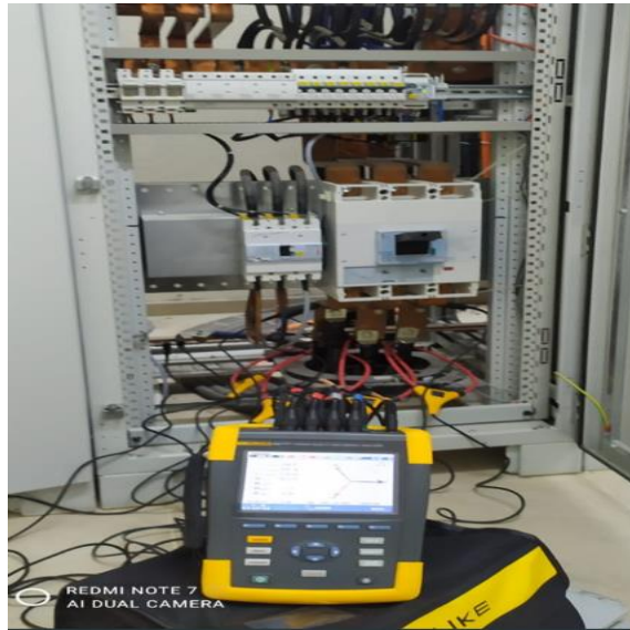
Şekil 5.2. Mühendislik fakültesi giriş şalteri enerji kalitesi ölçüm noktası
