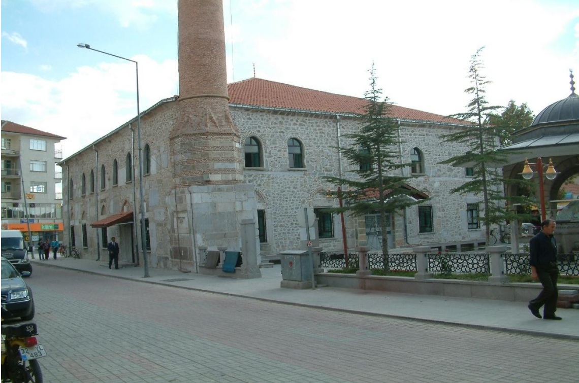
Resim 4.7 Devlethan Caminin kuzey cephesi görünüşü (Anonim (b) 2020).
