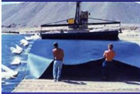
Şekil 5.14. Geomembran yerleştirimi (URL-5).
