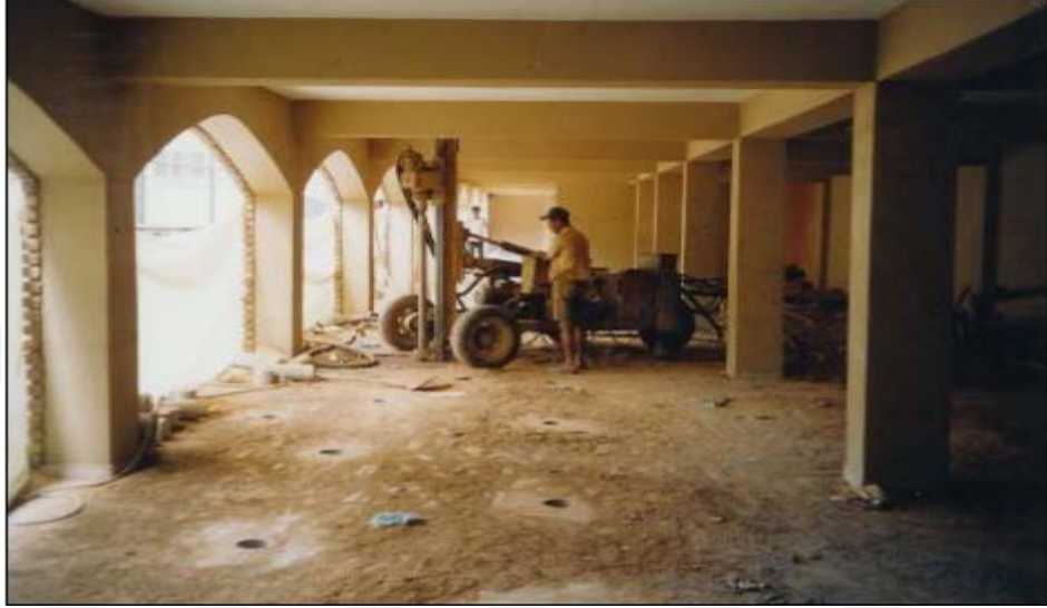
Şekil 5.6. Bina temeline mini kazık uygulaması (Öztürk, 2006).
