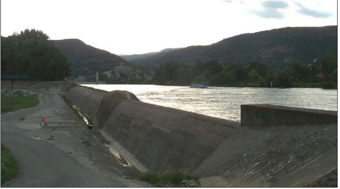
Şekil 2.1 Rhone Nehri (Fransa) üzerindeki beton yan dolu savak resmi (Rosier [4])
