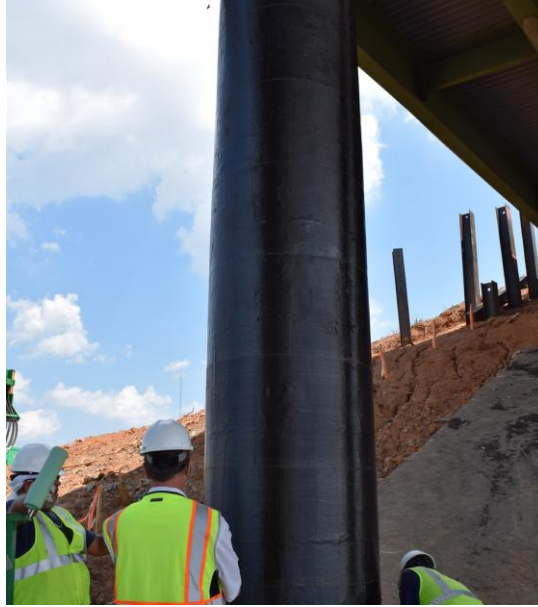
Şekil 2.11. Kolonda Bitmiş FRP Uygulaması [20]
