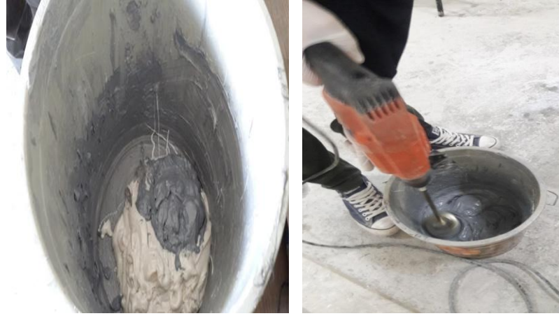
Şekil 4.14. Çift Bileşenli Epoksinin Hazırlanması
