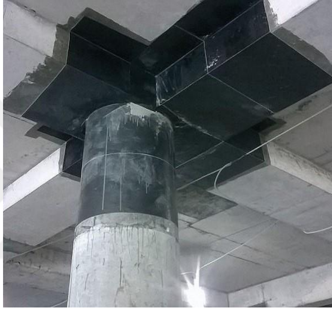
Şekil 2.12. Kolonda Bitmiş FRP Uygulaması [22]
