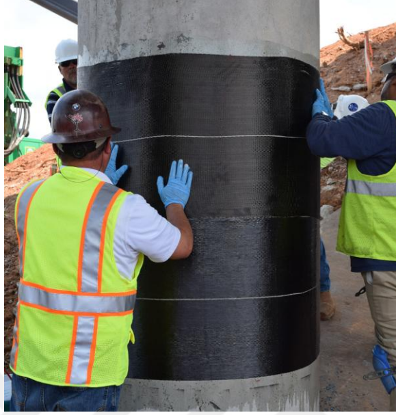
Şekil 2.10. FRP'nin Kolon Yüzeyine Uygulanması [20]
