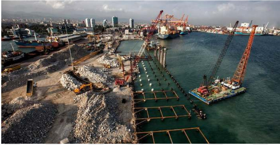
Şekil 1.1. Proje Sahası Genel Görünüş
