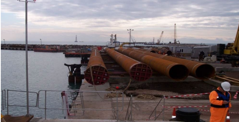
Şekil 3.8. Kazık Kaynak Sahası ve Yuvarlama Rampası
