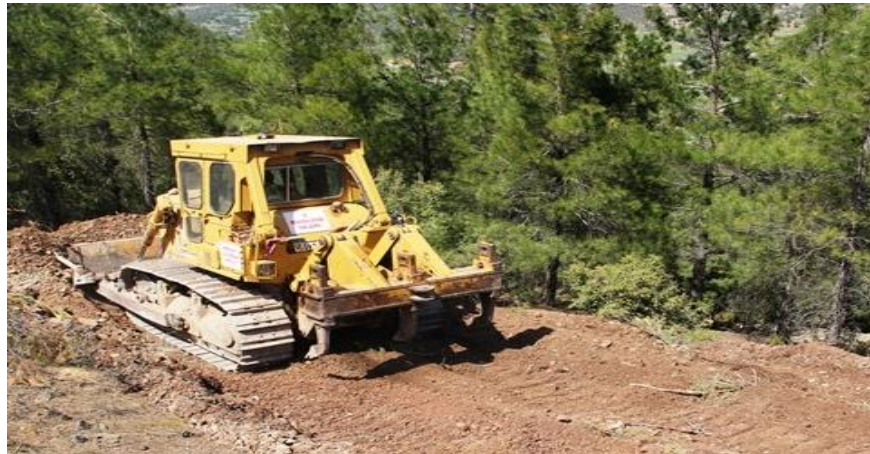
Şekil 2.24. Dozer (OGM İnternet sayfası)
