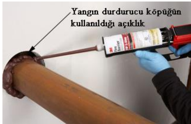
Şekil 4.16: Yangın durdurucu köpük kullanımı [4].
