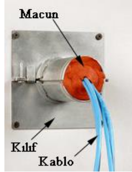
Şekil 4.34: Kablo etrafına uygulanmış kılıf içerisinde yangın durdurucu macun [4].
