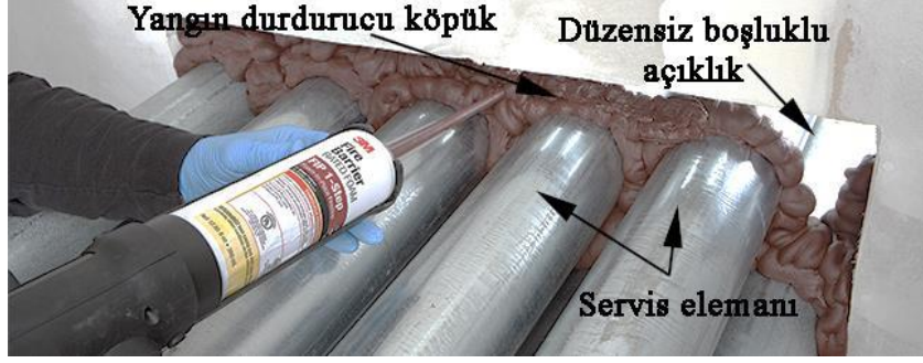
Şekil 5.9: Düzensiz şekilli zor ulaşılabilen açıklıklarda kolay uygulanan, uygulandıktan sonra şişerek tüm boşlukları kapayan yangın durdurucu köpük tercih edilebilir [60].
