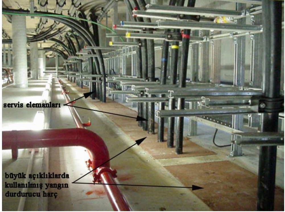
Şekil 3.9: Zemindeki büyük açıklıkları kapatmak için yangın durdurucu harç kullanımı [17].
