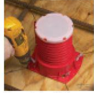
Geçiş aparatı üzerinde koruma şapkası ile kalıp üzerine sabitlenir
