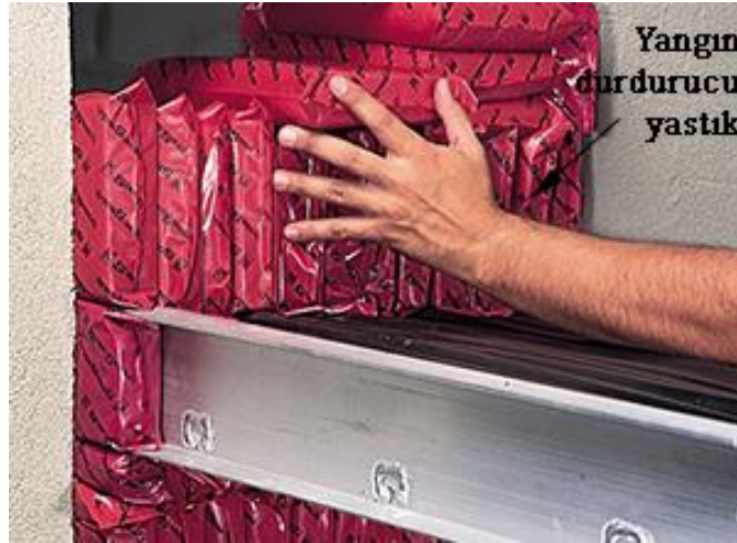
Şekil 4.39: Yangın durdurucu yastık uygulama örneği [47].
