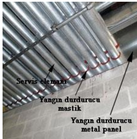
Şekil 4.46: Yangın durdurucu metal panel uygulaması [51].
