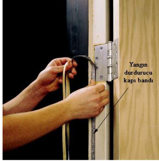
Şekil 4.56: İntümesan yangın durdurucu bant uygulaması [4].
