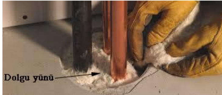
Şekil 4.58:Dolgu yünü uygulaması [4].
