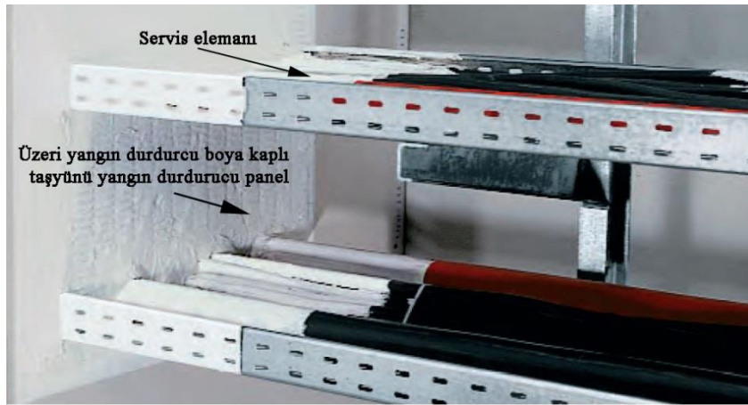
Şekil 4.45: Yangın durdurucu boyalı panel uygulaması örneği [3].
