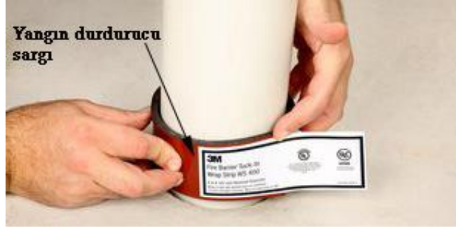
Şekil 4.24: Boruda yangın durdurucu sargı kullanımı [4].
