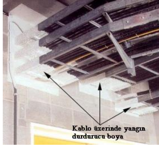
Şekil 4.10: Kablolar üzerinde yangın durdurucu spreysel boya kaplaması örneği [43].
