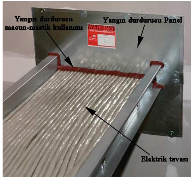
Şekil 5.8: Yangın durdurucu panel içerisinden geçen kablo tavaşı uygulaması [20].
