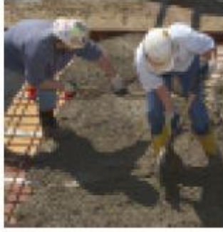
Döşeme betonu dökülür.
