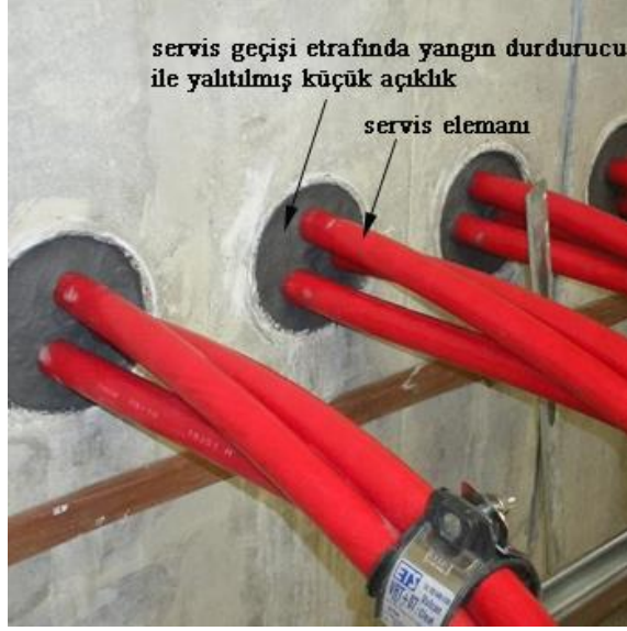
Şekil 3.6: Servis geçişi etrafında kalan küçük açıklık örneği [15].
