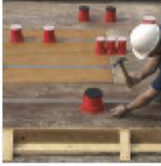
Döşeme yüksekliğine göre geçiş aparatının boyu ayarlanır
