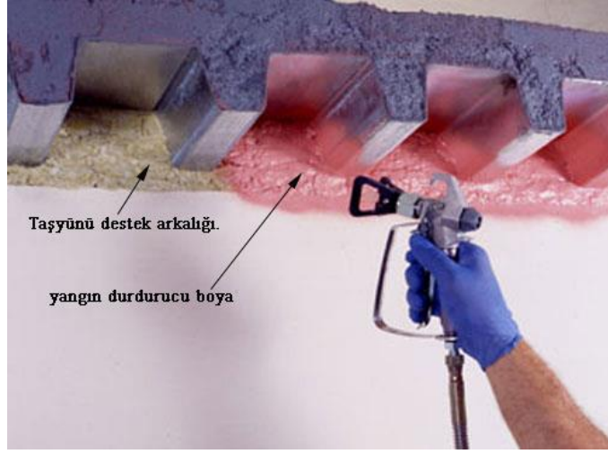
Şekil 4.11: Metal ondüle döşeme- duvar birleşiminde yangın durdurucu spreyci uygulaması [44].
