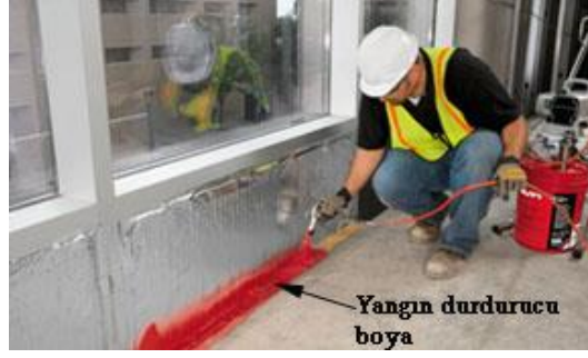
Şekil 4.9: Sprey tabancasıyla yangın durdurucu boya uygulaması [3].
