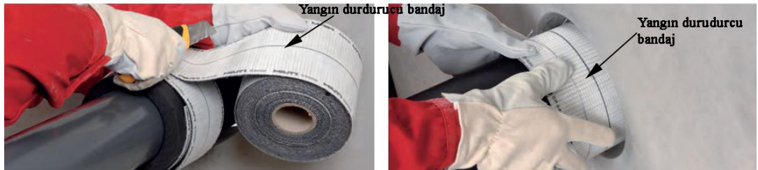
Şekil 4.27: Yangın durdurucu bandaj [3].
