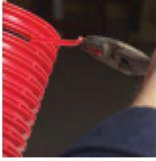
Döşeme yüksekliğine göre geçiş aparatının boyu ayarlanır
