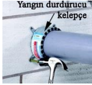
Şekil 5.12: Yangın durdurucu kelepçe [3].
