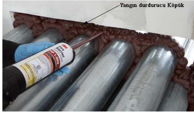
Şekil 4.14: Yangın durdurucu köpük uygulaması [45].
