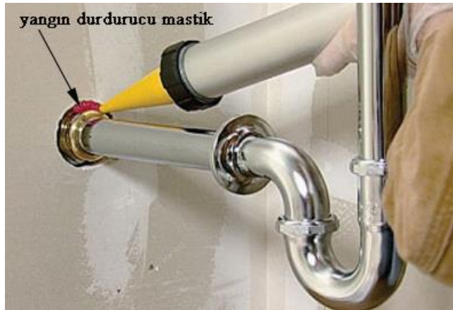
Şekil 4.1: Yangın durdurucu mastik [19]
