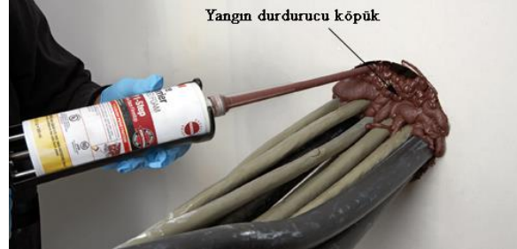
Şekil 4.15: Kablo araları gibi zor ulaşılabilecek karmaşık şekilli açıklıklarda yangın durdurucu köpük kullanılabilir [46].
