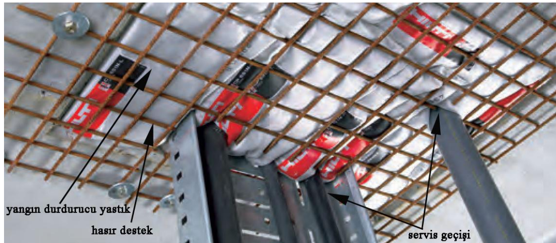
Şekil 4.41: Yangın durdurucu yastık döşeme üzerinde uygulandığı zaman alttan çelik hasırla desteklenmelidir [3].
