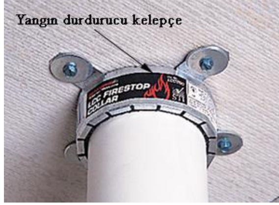
Şekil 4.17: Yangın durdurucu kelepçe [47]
