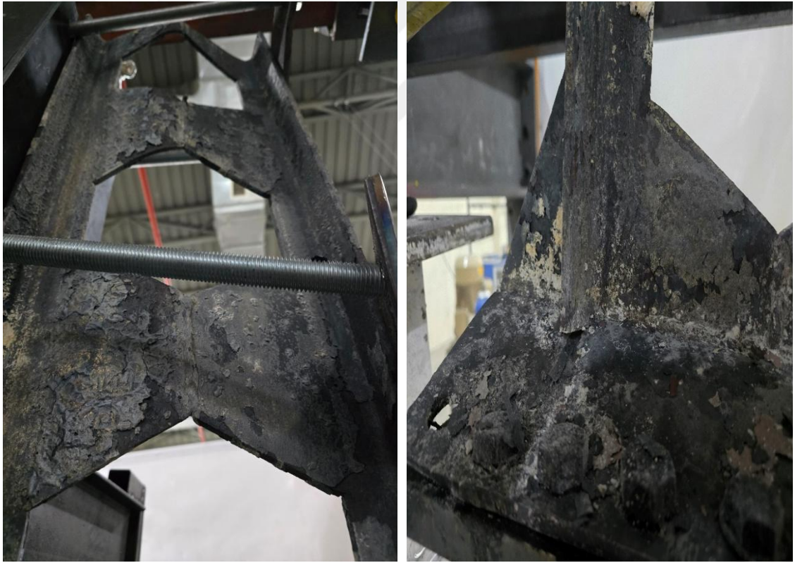
Şekil 21. IPE 200-P-BK-Y numunesine ait göçme modu davranışı
