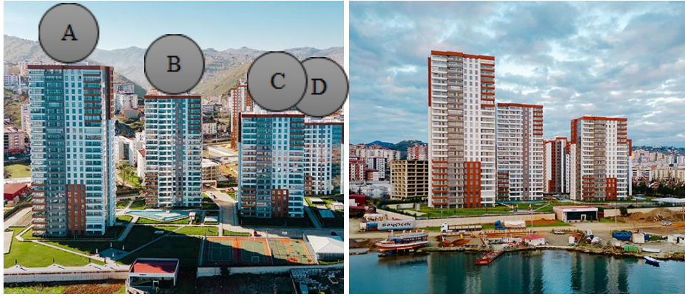
Şekil 32. Site yerleşkesi birinci etap A, B, C, D blokları ve Trabzon sahilini
