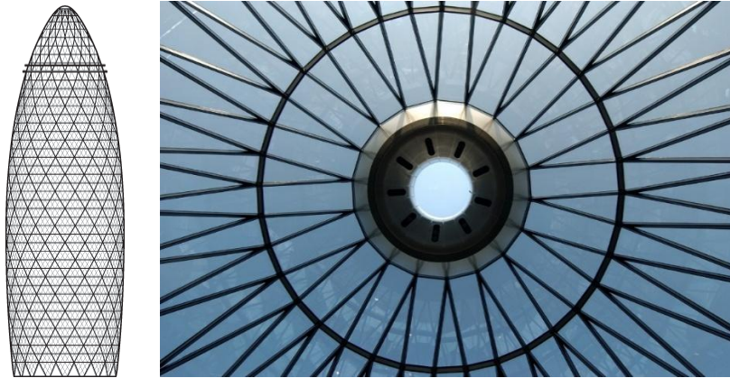
Şekil 64. 30 St Mary Axe (Foster+Partners) diagrid çerçeve strüktürel yapısı ve yapının tepesinde yer alan çelik halka strüktür (URL-4)
