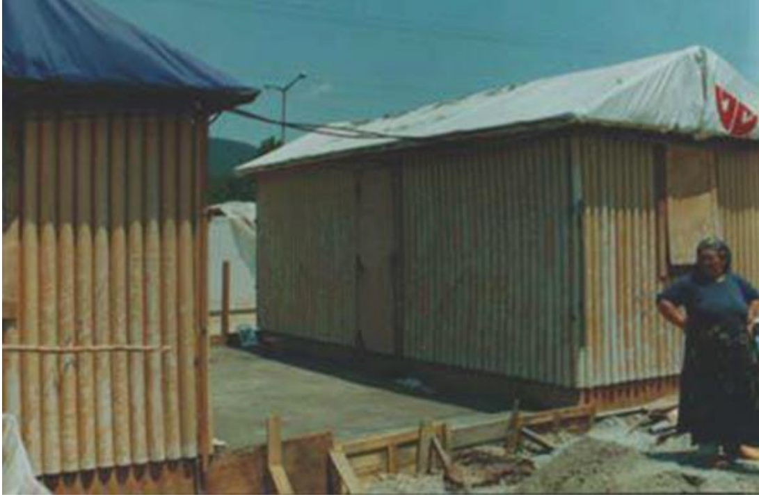
Şekil 3.17: Kullanım sırasında iki birim arasında banyo ve mutfak yapılması için dökülen beton temel (Johnson,2005)
