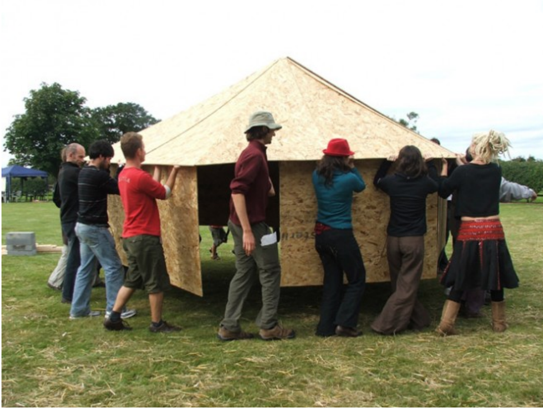
Şekil 4.4: Hexayurt barınağının montajından sonra taşınması (URL 16)
