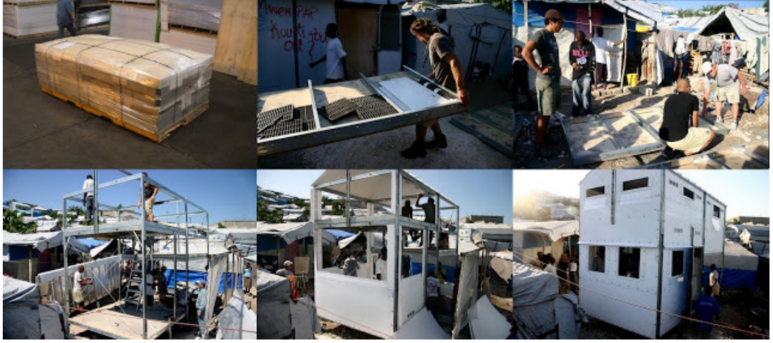
Şekil 3.11: Barınağın montaj aşamaları (URL 12)
