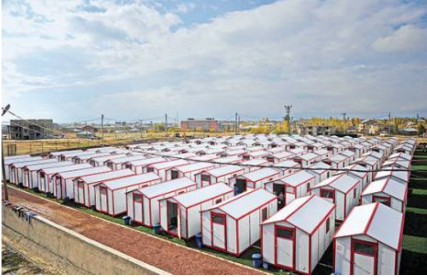
Şekil 3.14: 1999 Depremi sonrası kurulan konteyner yerleşkesi (Erginöz, 2005)
