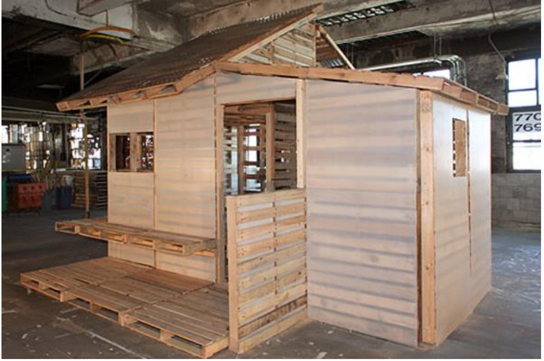
Şekil 4.2: Oluşturulan strüktür üzerine kaplama malzemesinin montajı (URL 14)
