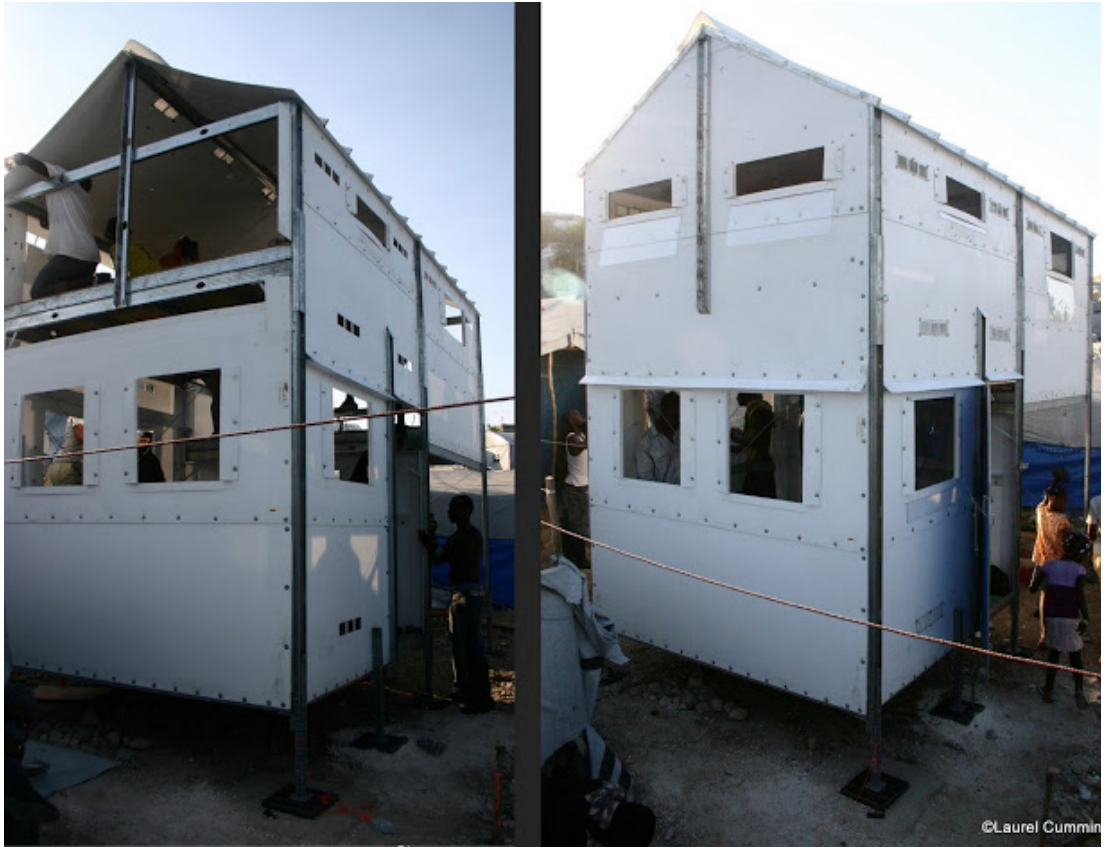
Şekil 3.12: Barınak kabuğunun montajı (URL 12)
