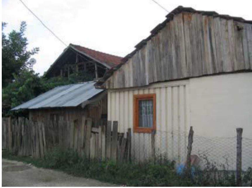
Şekil 3.15: 1999 Gölçük Depremi sonrası konteyner barınaklar gerekli eklemeler yapılarak kalıcı konuta çevrilmiştir (Johnson,2005).
