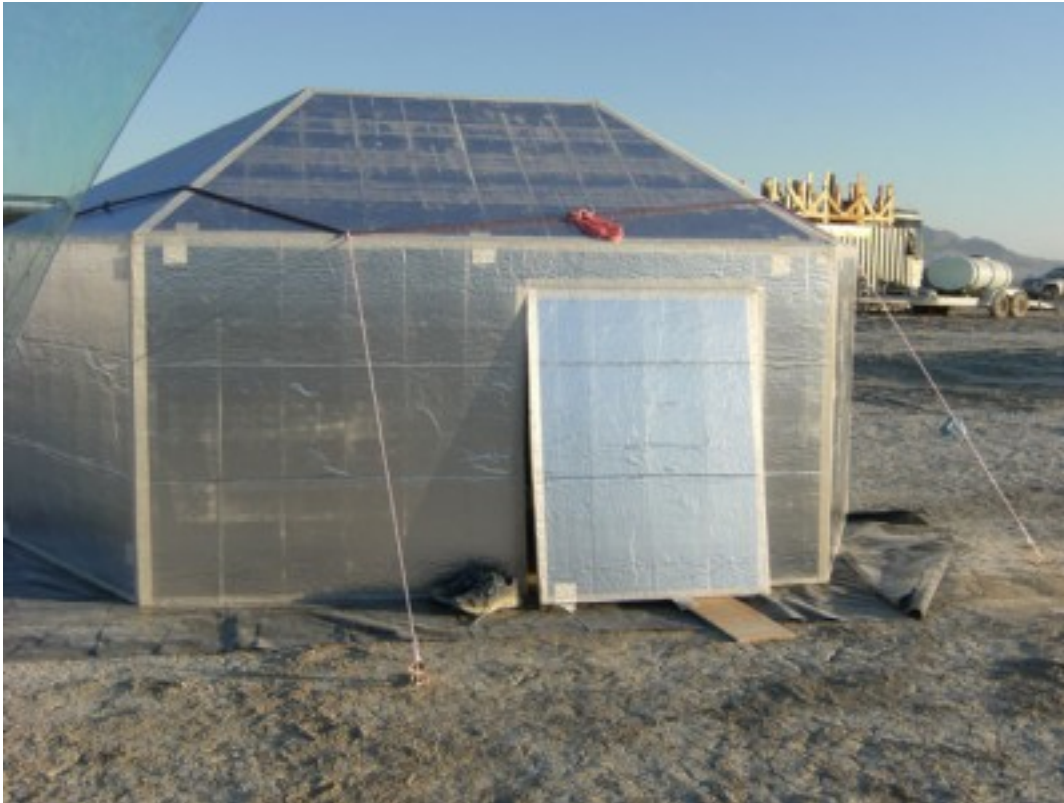
Şekil 4.5: Barınağın metal bant kullanılarak yalıtılması (URL 16)
