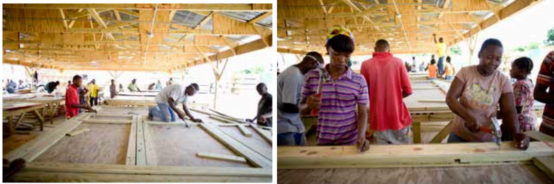
Şekil 4.7: Gönüllüler ile geçici barınak yapım aşaması (Boyd ve Hofknecht, 2011)
