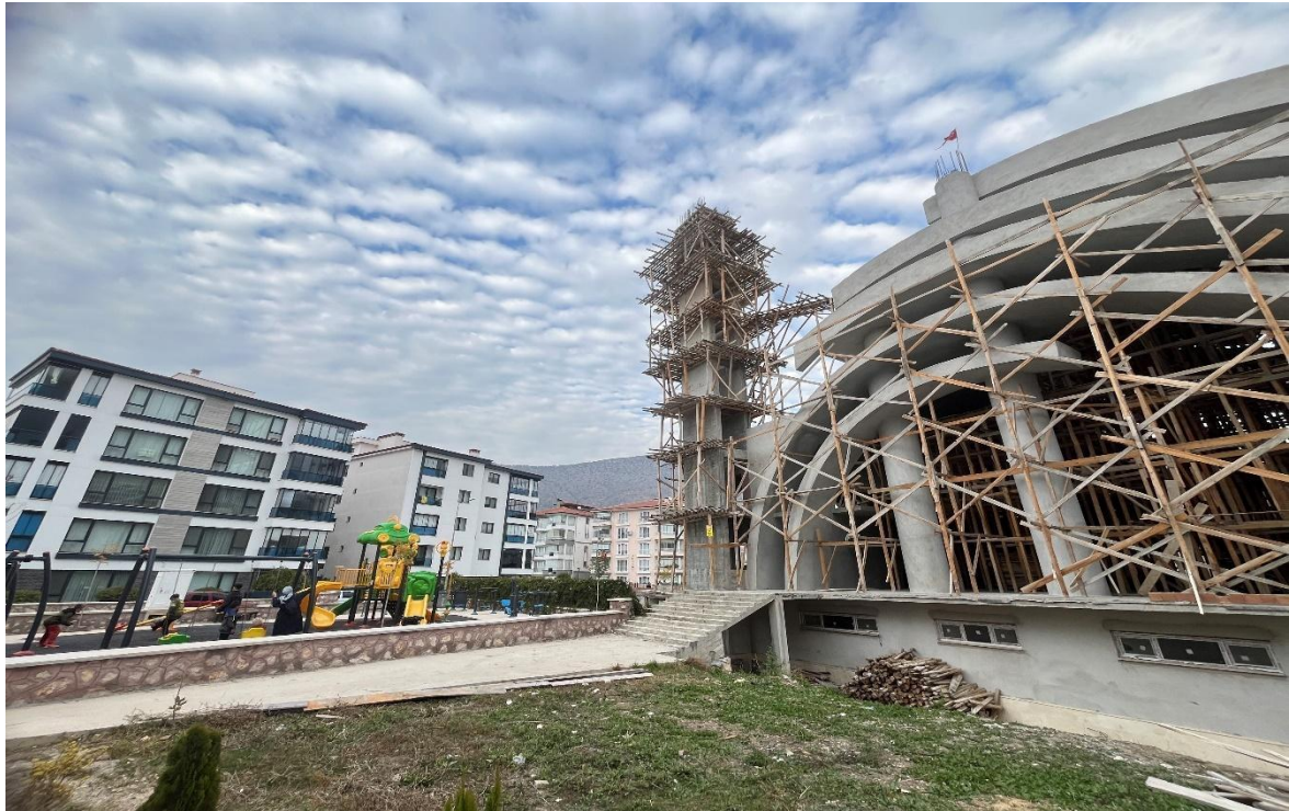
Şekil 4.22. İnşaat sahasının sosyal alanların yanında olmasına ait şekil
