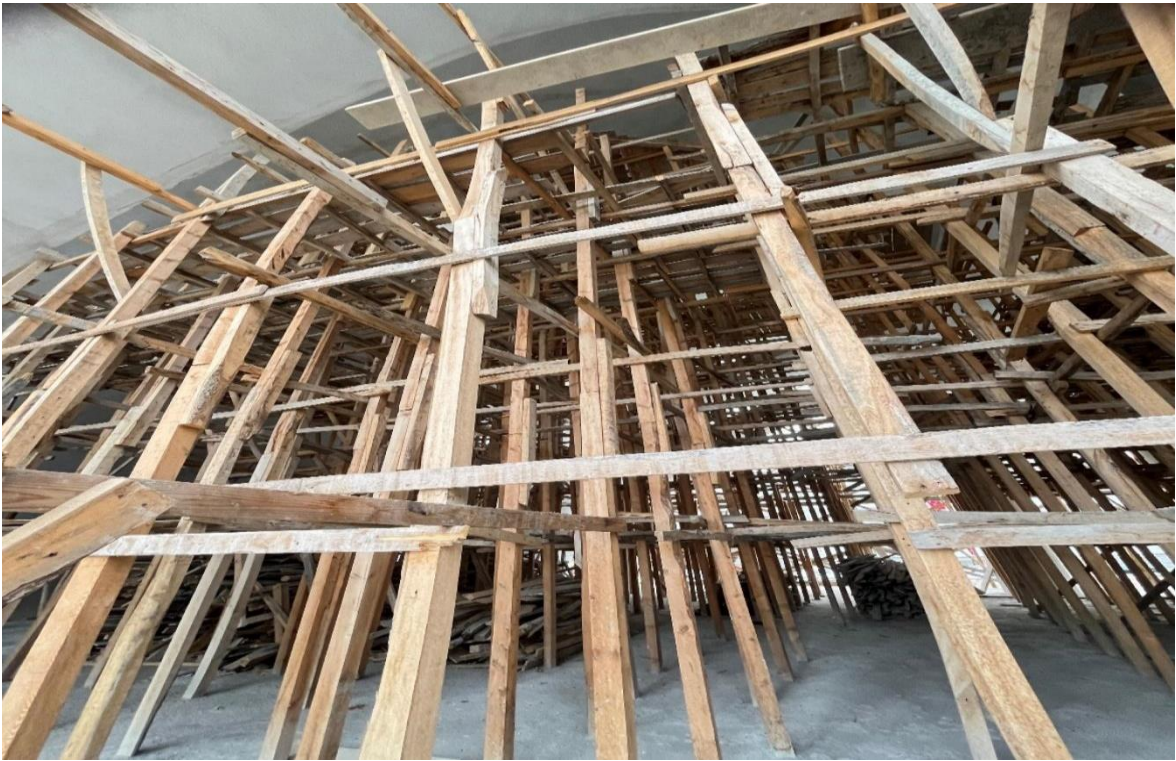
Şekil 4.5. Ahşap iskele kullanılmasına ait şekil
