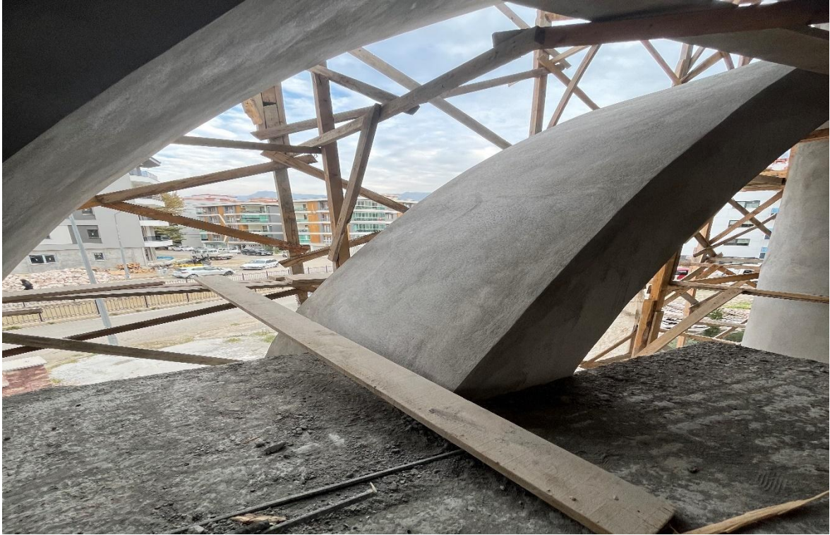
Şekil 4.11. Eğrisel taşıyıcı sistemlere ait şekil
