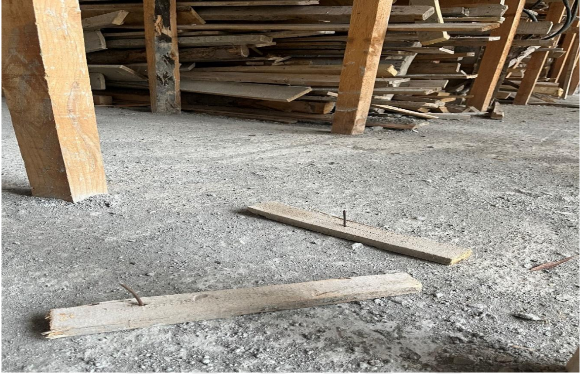
Şekil 4.8. Kullanılan tahtalardaki çivi güvenliđine ait şekil
