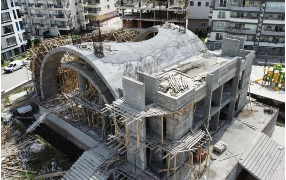
Şekil 4.13. Geniş döşeme açıklıklarına ait şekil
