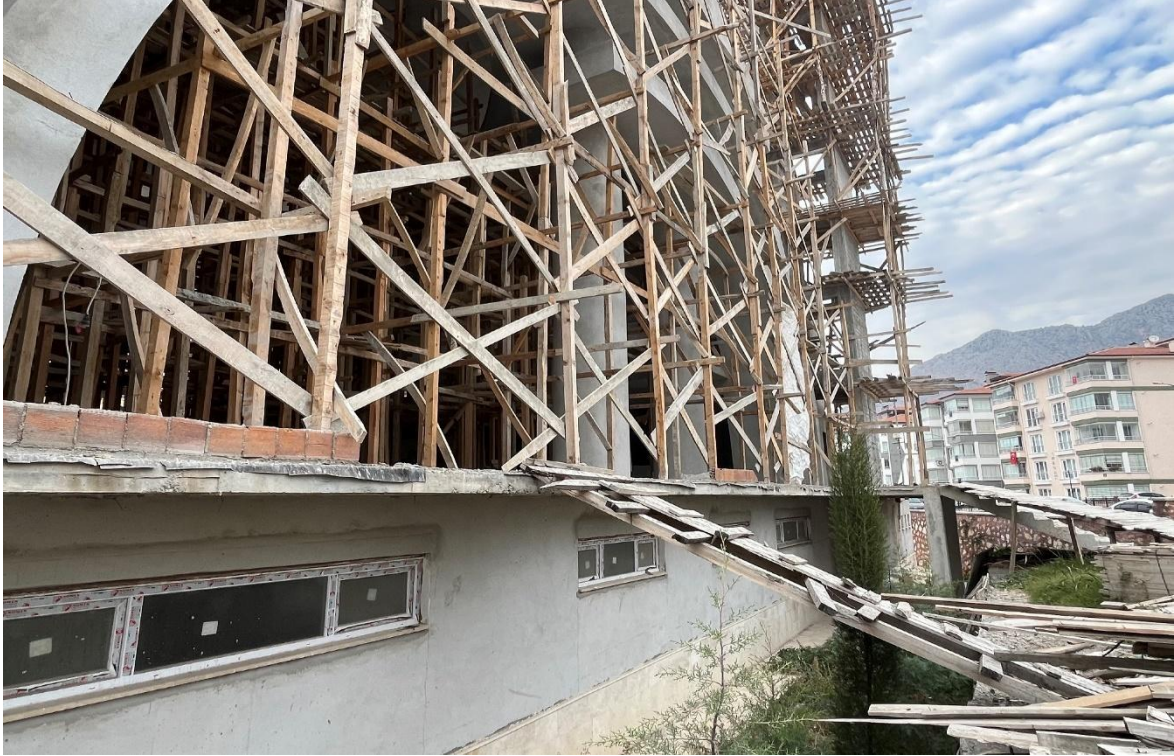
Şekil 4.18. İnşaat sahasının giriş merdivenine ait şekil
