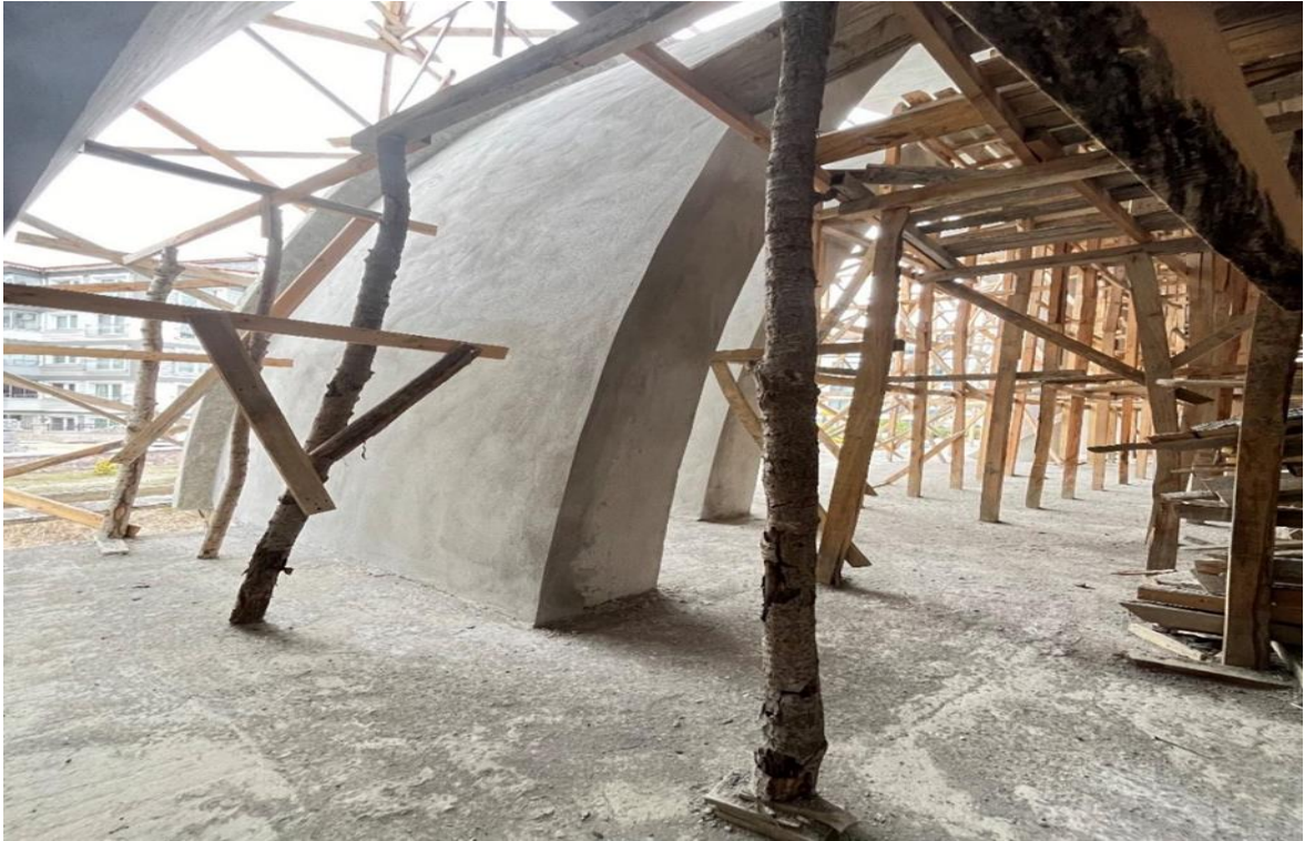
Şekil 4.4. Ahşap iskele kullanılmasına ait şekil
