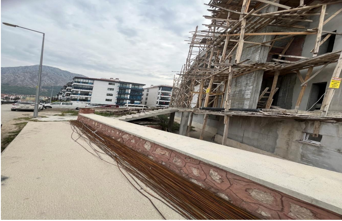
Şekil 4.19. Düzensiz malzeme istifine ait şekil
