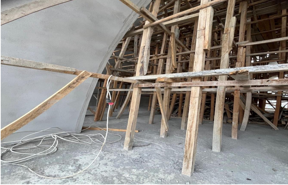
Şekil 4.14. Düzensiz elektrik kablolarına ait şekil
