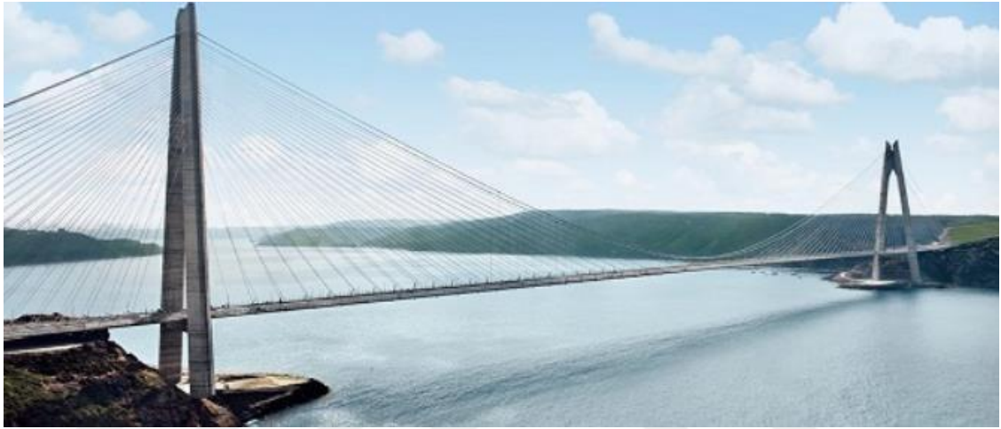
Şekil 2.6. YİD projesi çerçevesinde hizmete sunulan Yavuz Sultan Selim Köprüsü (Anonim 4)
