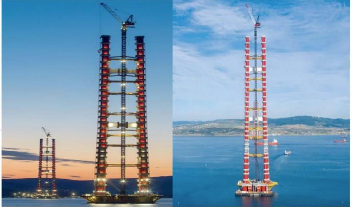
Şekil 3.5. 1915 Çanakkale Asma Köprüsü kule son imalatı (Anonim 27)
