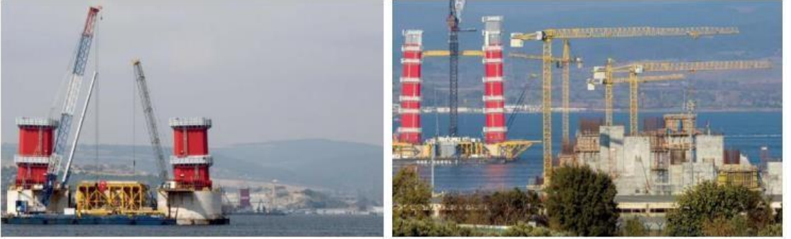
Şekil 3.4. 1915 Çanakkale Asma Köprüsü kule imalatları (Anonim 27)
