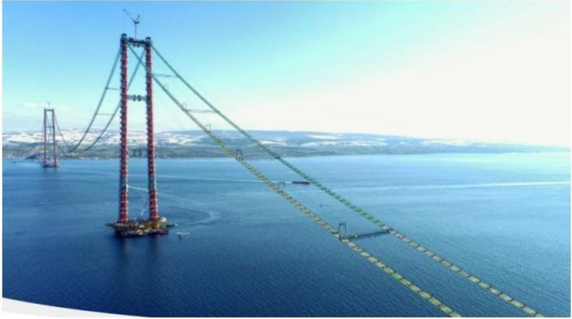
Şekil 3.6. 1915 Çanakkale Asma Köprüsü kedi yolu (Anonim 27)
