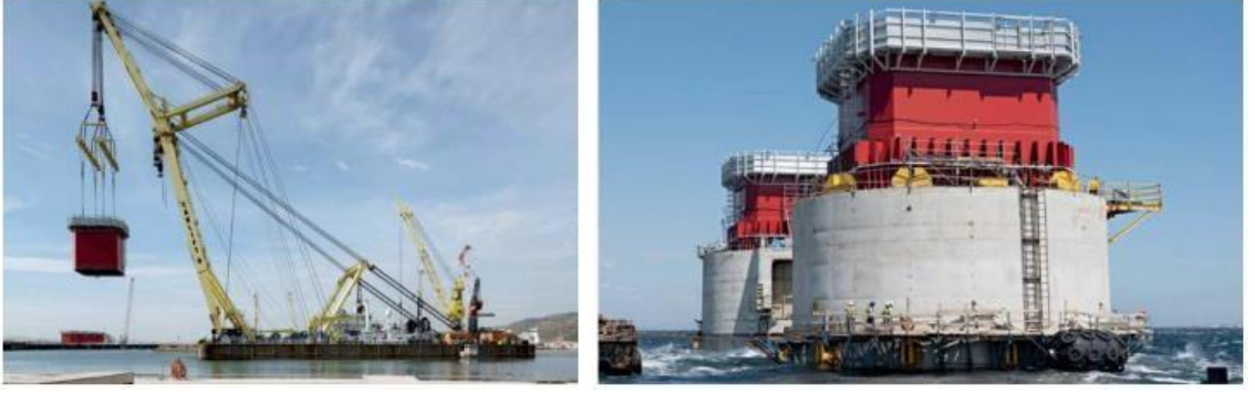
Şekil 3.3. 1915 Çanakkale Asma Köprüsü kule ilk imalatı (Anonim 27)
