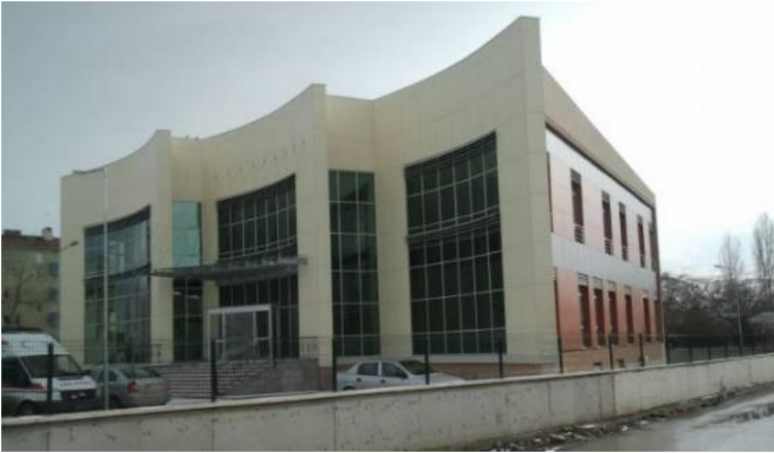
Şekil 69. 10 Yataklı Hastane Binası
