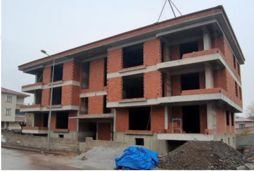
Şekil 51. 4 Katlı Konut Binası Kaba İnşaat Fotoğrafı
