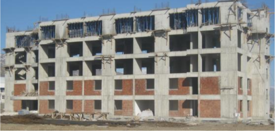
Şekil 33. 500 Kişilik Yurt Kaba İnşaat Fotoğrafı
