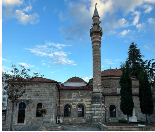
Şekil 84. İskenderpaşa Cami'sine ve minaresine ait görüntü
