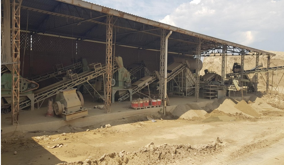
Resim 1.4 İpek Tuğla Fabrikası hammadde hazırlama ünitesi
