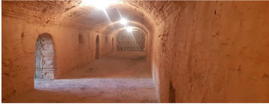
Resim 1.7 İpek Tuğla Fabrikası Hoffman fırını
