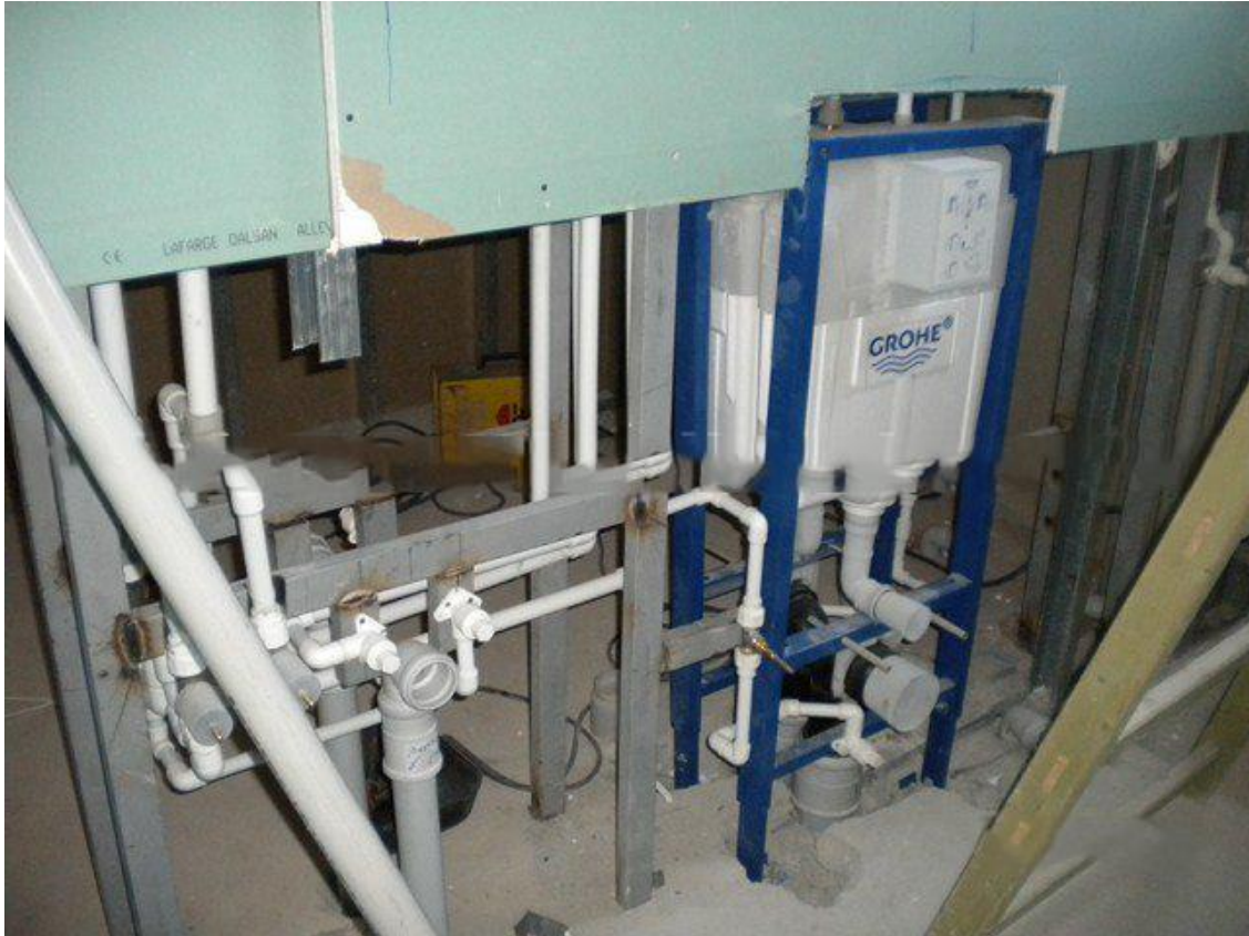
Şekil 2.6 : Bölme duvar sistemleri ile mekanik tesisat birleşimleri.
