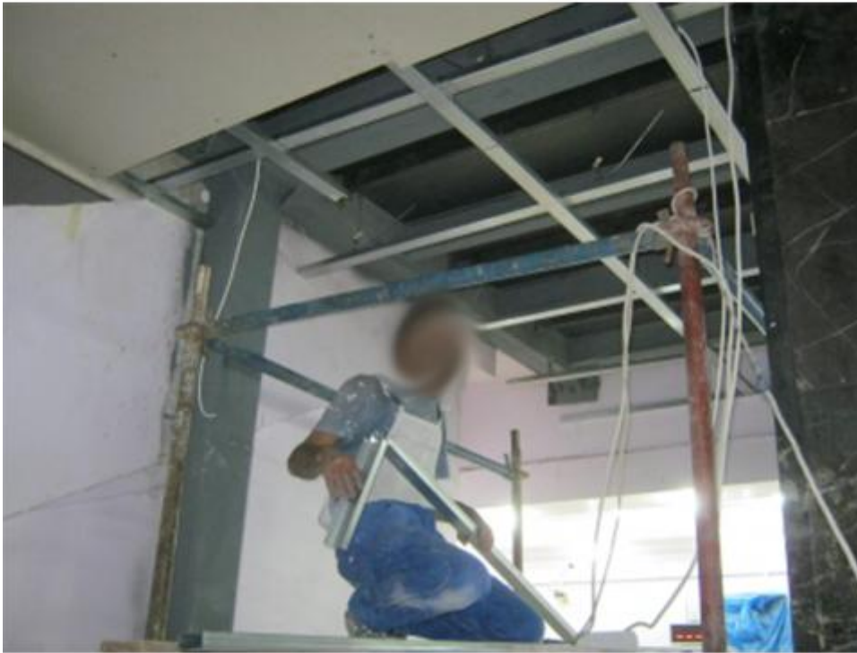
Şekil 2.7 : Elektrik sistemi ile bölme duvar sistemleri birleşimi.
