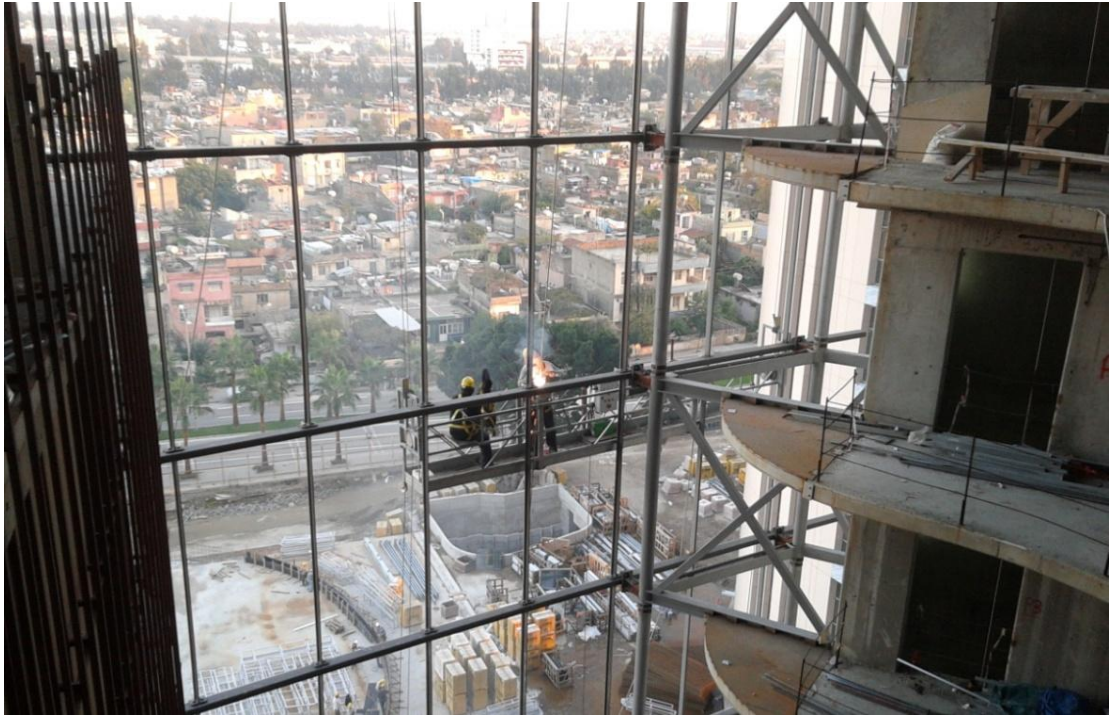
Resim 4.2. Asma sepette cephe çelik çalışması
