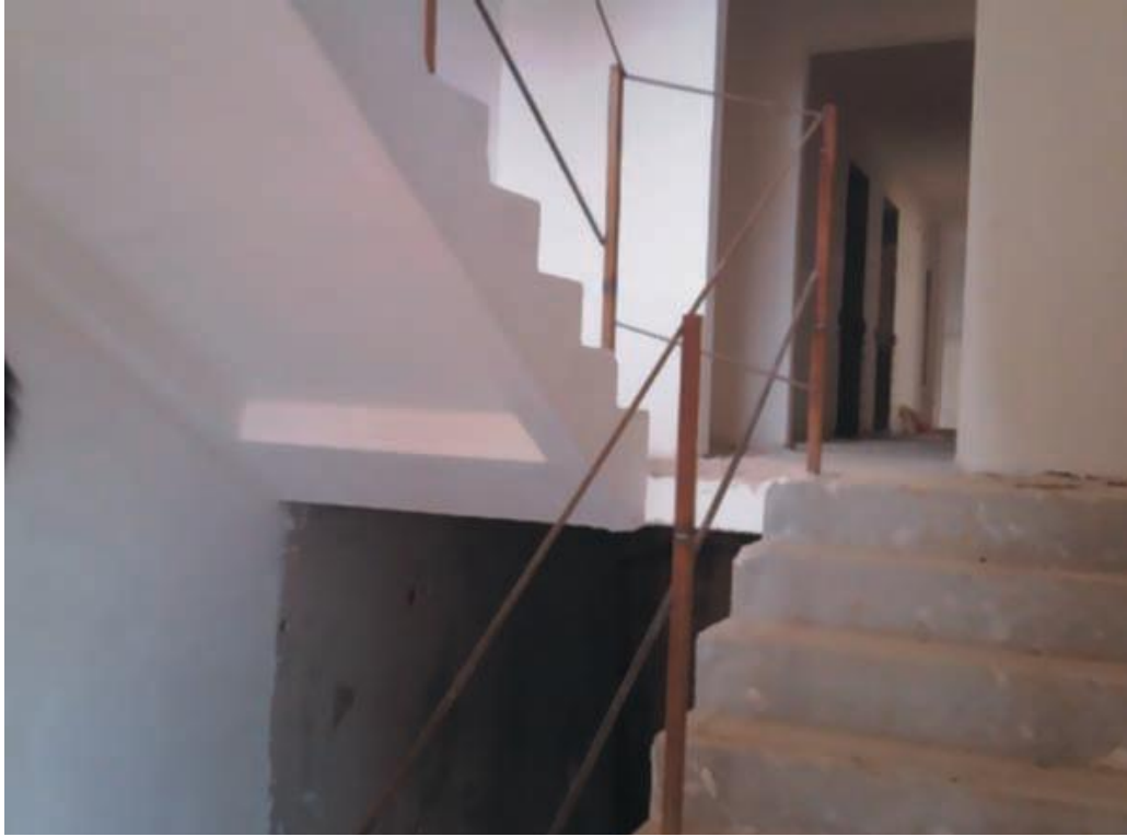
Resim 2.4. Denetim sonrası yapı inşaatı merdivenler
