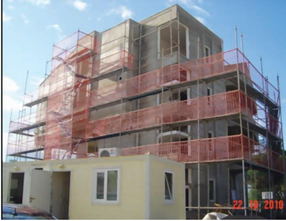
Resim 2.2. Denetim sonrası yapı inşaatı dış cephe
