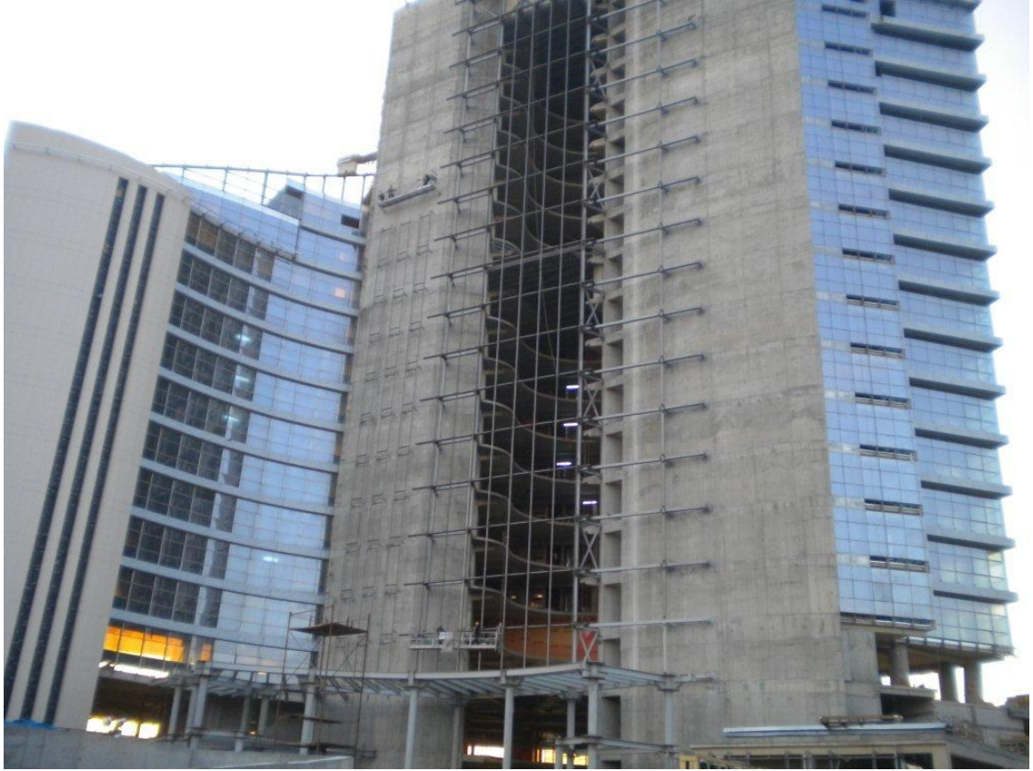
Resim 4.1. Adana Sheraton Otel cephe kaplama çalışmaları
