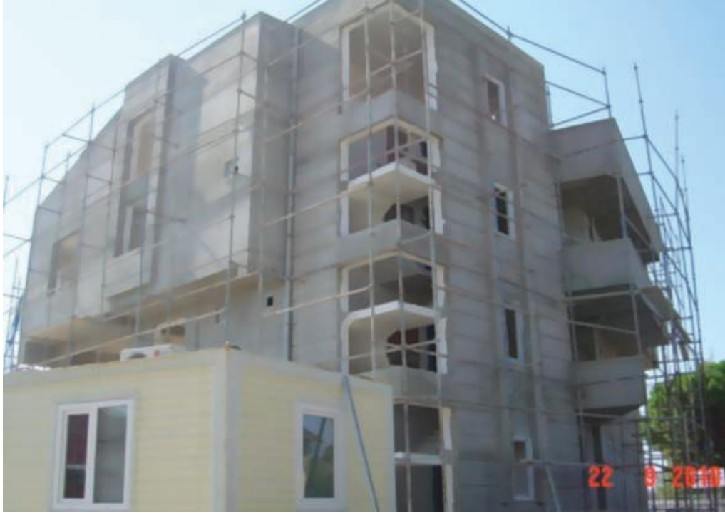
Resim 2.1. Denetim öncesi yapı inşaatı dış cephe
