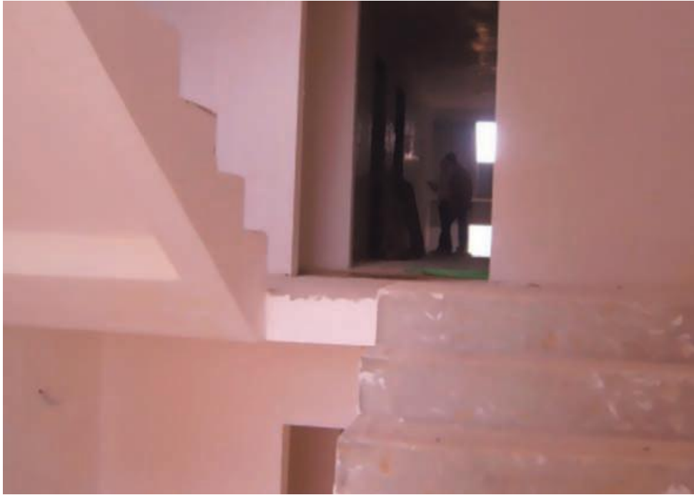
Resim 2.3. Denetim öncesi yapı inşaatı merdivenler
