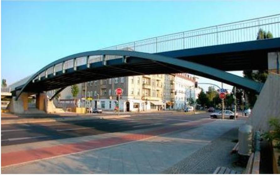
Şekil 8. Britzer Damm yaya köprüsü (URL-2, 2022).
