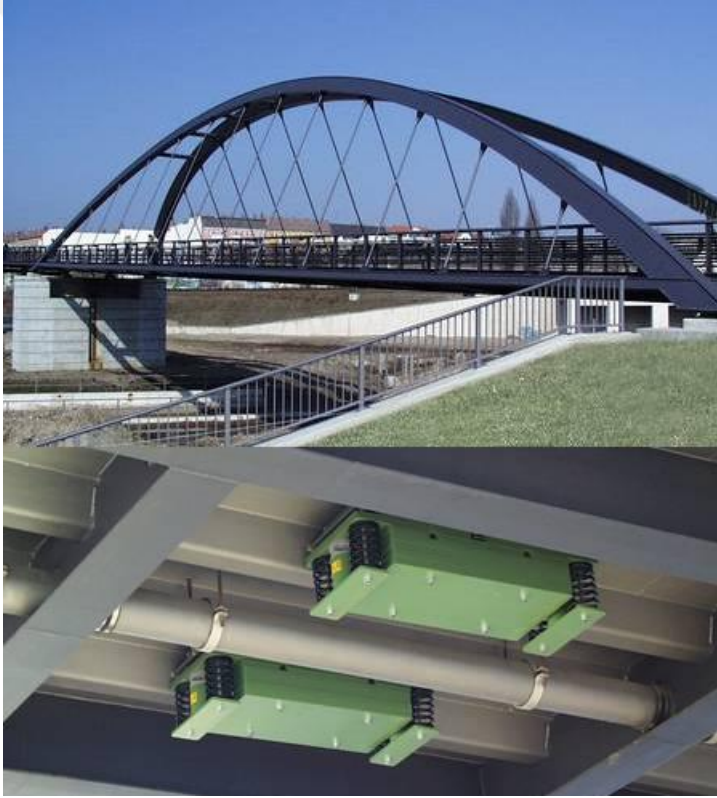
Şekil 9. Schwedter Straße Köprüsü (URL-2, 2022).
