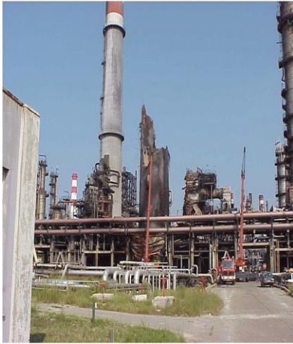
Şekil 1. Deprem sonucu yıkılan bir betonarme sanayi bacası örneği (Gould vd. 2004)
