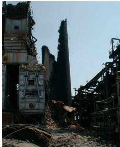
Şekil 1. Deprem sonucu yıkılan bir betonarme sanayi bacası örneği (Gould vd. 2004)
