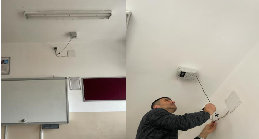
Resim 3. 3. Gerçek zamanlı hava kalitesi ölçüm sisteminin sınıflara montajı ve elektrik bağlantısının yapılması
