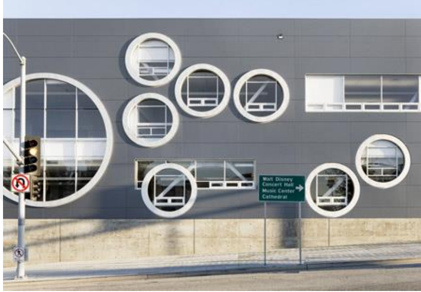
řekil 32. Cephe Grnř Dairesel pencereler (URL-25)
