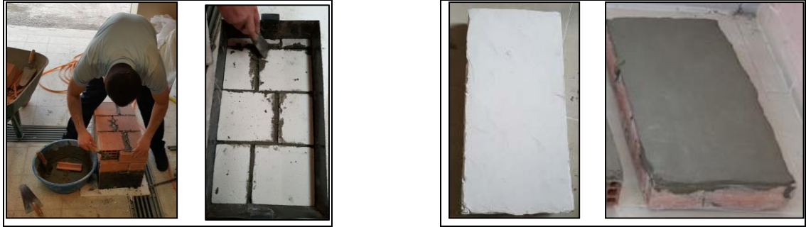
Tuğla, gazbeton duvar örümü
