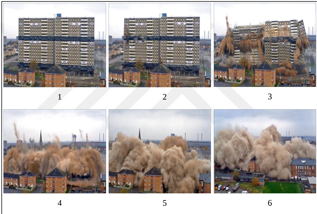
Şekil 5.1 Patlatma ile yıkım işlerinde oluşan toz bulutu (Yıkım-Hd, 2016)
