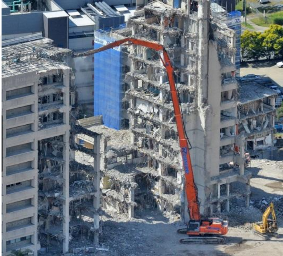
Şekil 3.8 Yüksek noktalara erişebilen iş makineleri ile yıkım (Rosenlund, b.t.)
