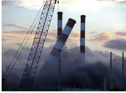
Şekil 3.9 Kuleler yardımı ile yıkım (Lasher, 2013)
