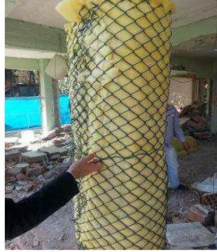
Şekil 5.12 Gürültüyü azaltmak amacıyla elemanlara cam yününün sarılması (Özyurt, 2013)
