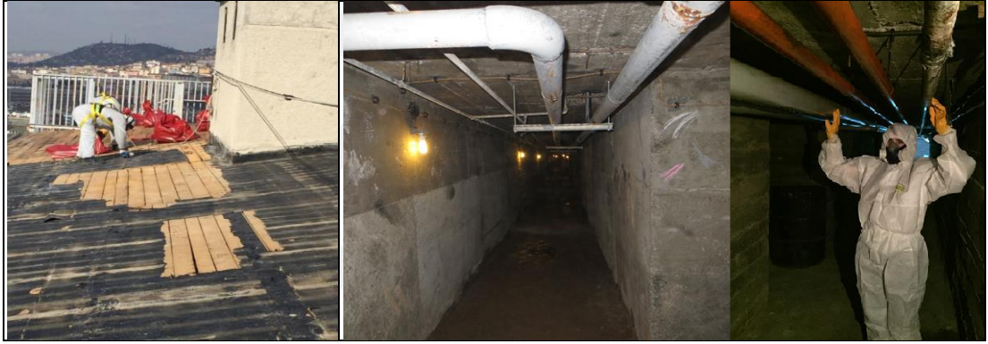
Şekil 5.20 Asbest sökümü (Yeşilyurt, 2016)
