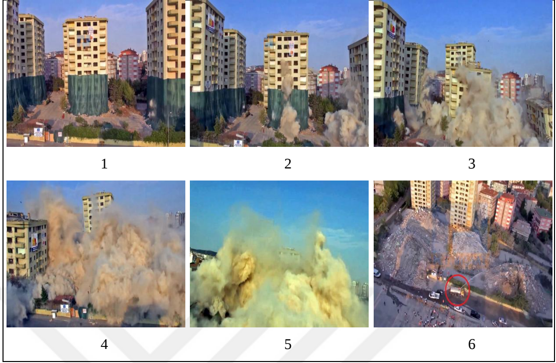
Şekil 5.3 Patlatma gerçekleşmeden önce yapının uygun bir örtü ile sarılması ve patlatma sonrasında oluşan molozların sulanması (6) (M.T.-inşaat-tanıtım, 2014)
