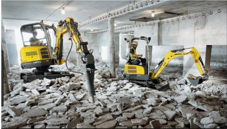
Şekil 3.6 Küçük iş makineleri ile yıkım (Meconstructionnews, 2015)
