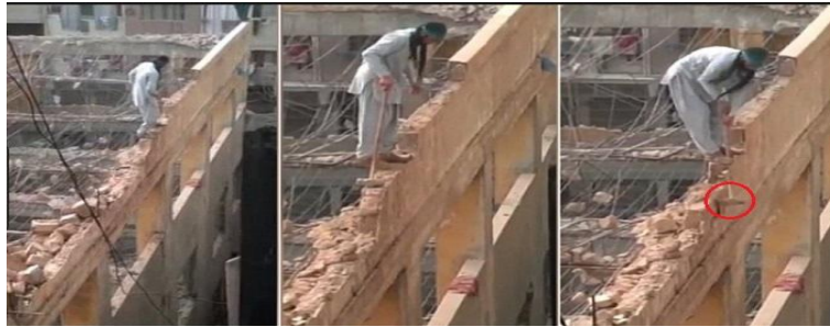
Şekil 3.12 İş güvenliği önlemleri alınmadan elle yıkım uygulaması (Reporter, 2016)
