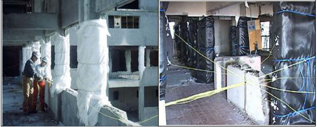
Şekil 5.18 Patlayıcı yerleştirilen kolonların koruyucu malzemelerle sarılması (Koca, 2006)
