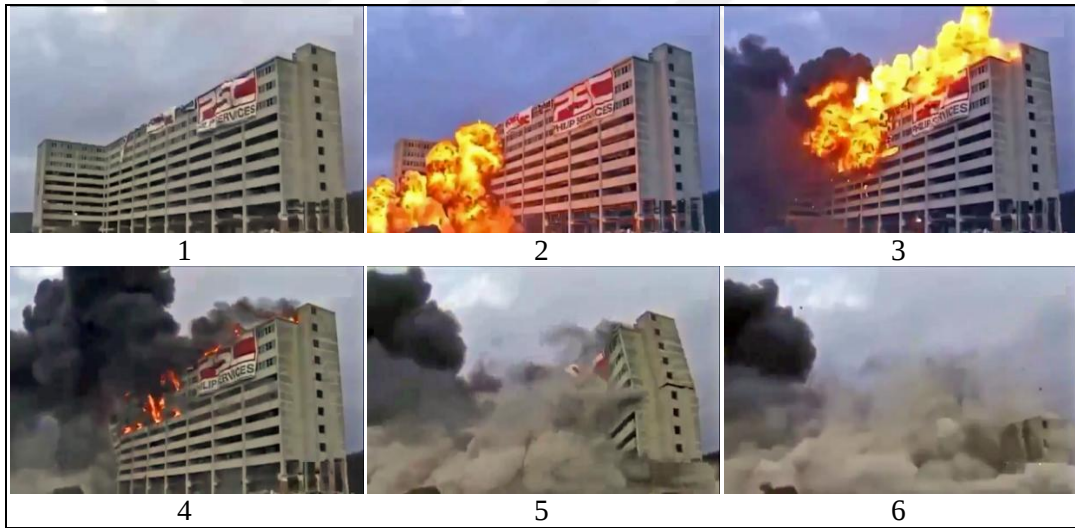
Şekil 5.14 Patlatmalı yıkım sırasında oluşan yangın ve zehirli duman (Sokaktaki-Mimar, 2018)
