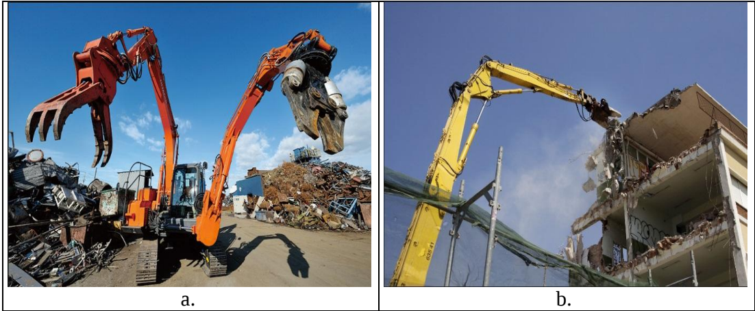
Şekil 3.11 a. Kesme ve tutma işlemlerine yarayan iş makineleri (Hitachicm, b.t.); b. Dev iş makinesi ile yıkım (Robore, b.t.)
