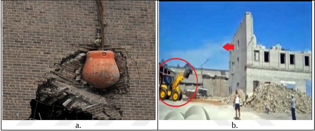
Şekil 3.10 a. Gülle ile yıkım (Rolfe, 2013); b. Çekme halatı ile yıkım (Lockwood, 2016)
