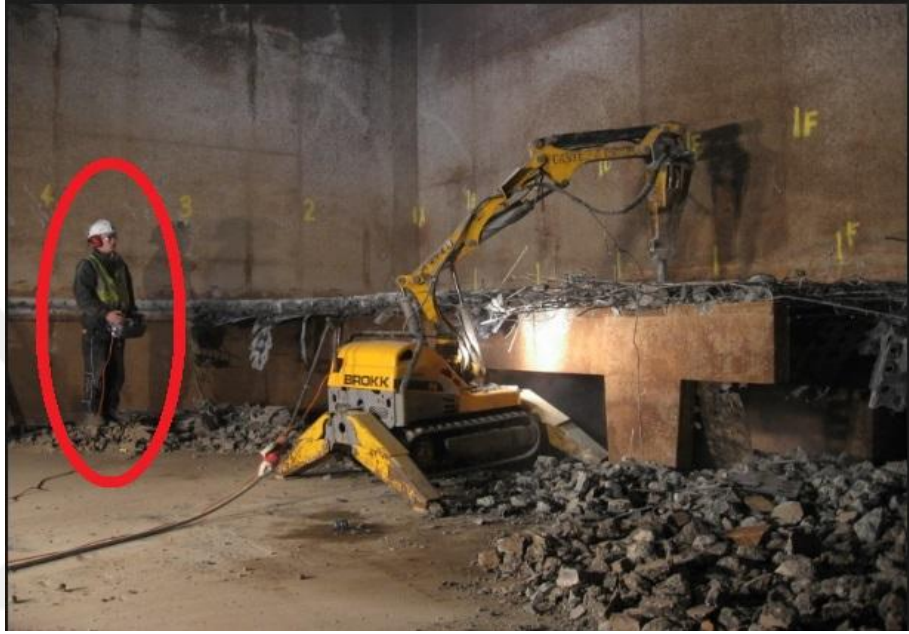
Şekil 3.5 Kumanda yardımı ile robotik makinelerle yıkım (Ramservices, b.t.)
