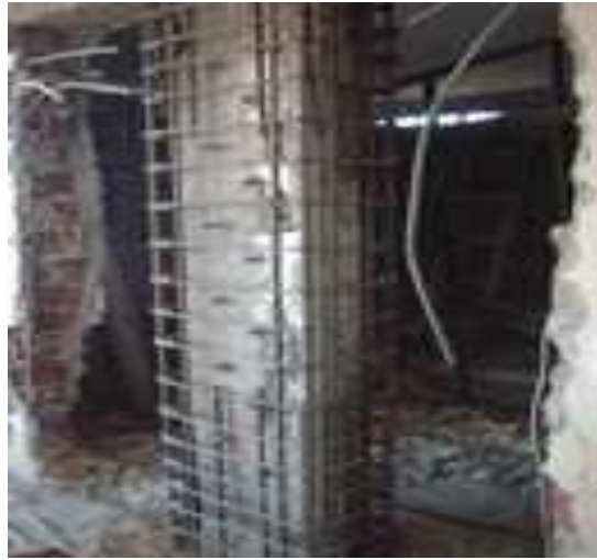
Şekil 2.2 Betonarme yapıda kolona mantolama yapılması (Kocaman 2008)
