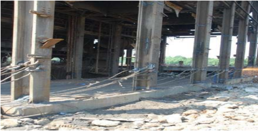
Şekil 8. Çekme halatı ile yıkım
