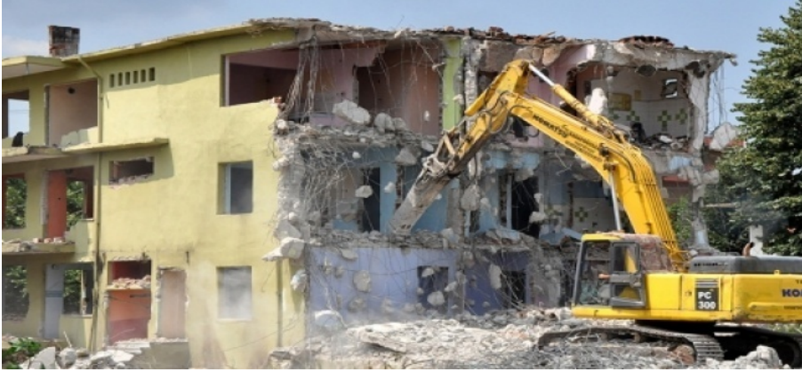
Şekil 4. Mekanik aletler ile yıkım
