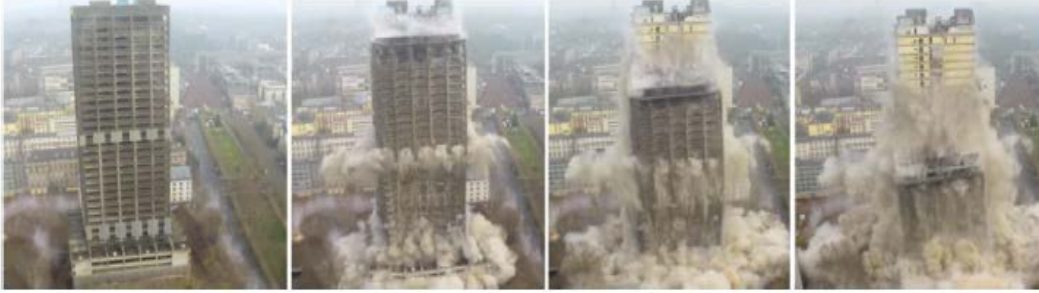
Şekil 13. Yapının kendi sınırları içerisinde göçmesi
