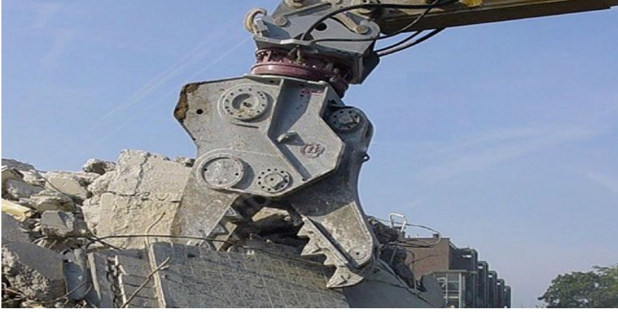
Şekil 6. Beton makası ile yıkım
