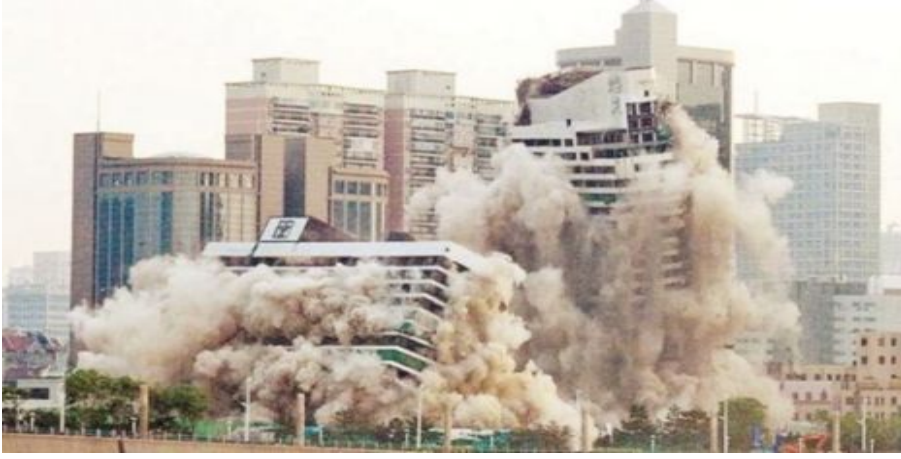
Şekil 9. Patlayıcı ile yıkım
