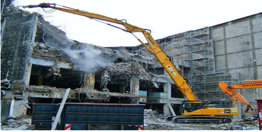
Şekil 7. Yüksek erişimli makine ile yıkım
