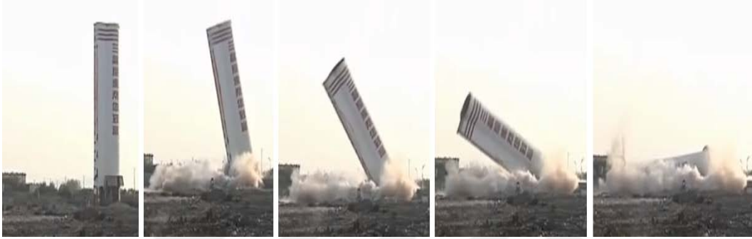
Şekil 15. Yapının belli bir yöne devrilerek yıkılması
