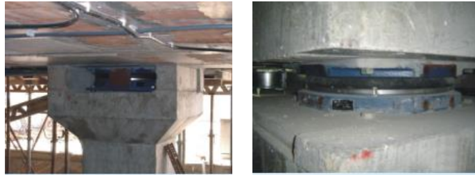
Şekil 2.7. Kocaeli Üniversitesi Tıp Fakültesi Binası taban izolasyon uygulaması (Kan ve ark, 2017).
