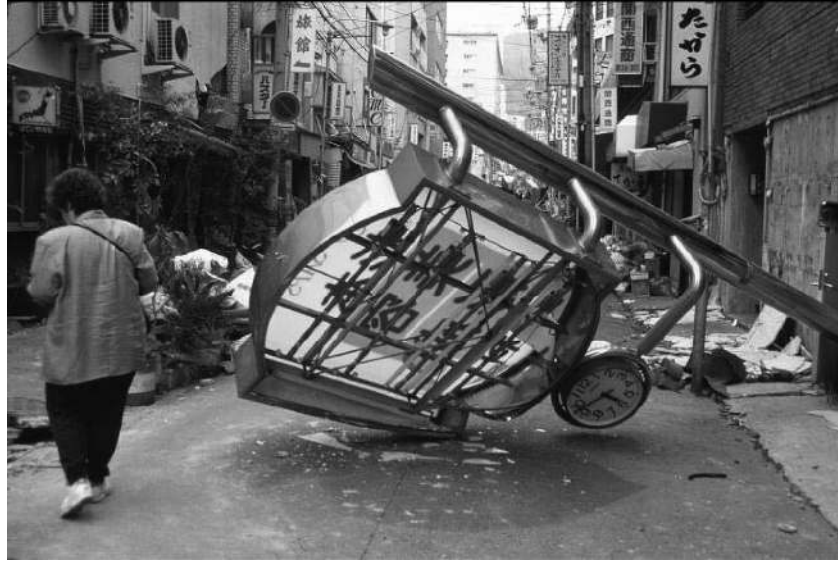
Şekil 1.3 1995 Kobe Depremi'nde yola düşen pano (Villaverde, 2004).
